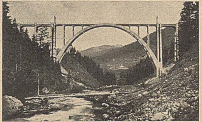
Abb. 5. Talbrücke bei Langwies, Chur—Arosa-Bahn, l = 100 \text{ m} .
