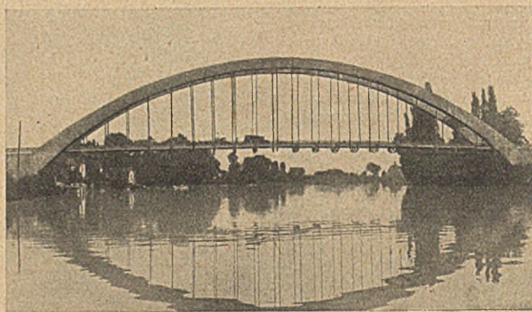
Abb. 9. Seinebrücke bei St.-Pierre-du-Vauvray, l = 131,8 m.
