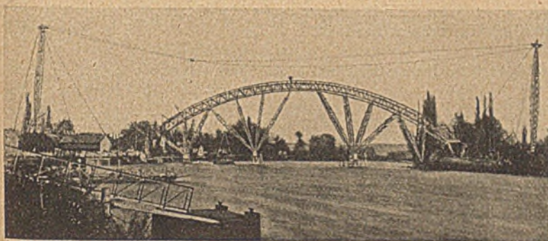
Abb. 13. Gesamtansicht des Lehrgerüsts der Seinebrücke bei St-Pierre-du-Vauvray.
