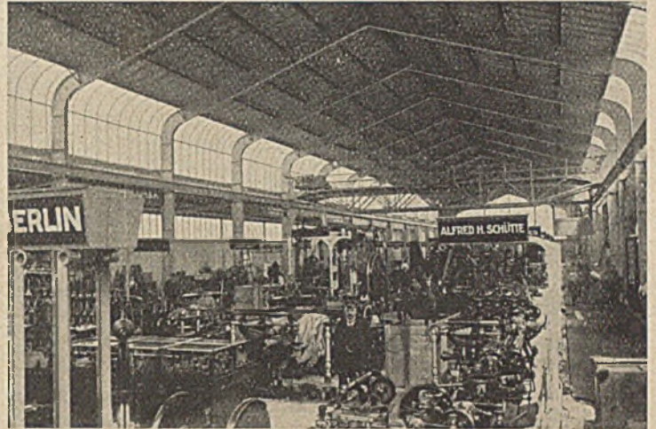
Abb. 1b. Maschinenhalle der W. B. A. Köln 1914.
