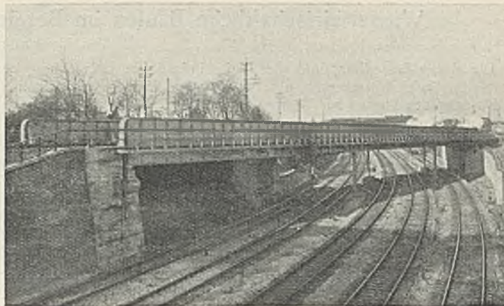
Abb. 8. Kreuzungsbauwerk bei Langenfelde.
