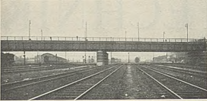
Abb. 3. Überführung der Monumentenstraße in Berlin.
