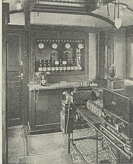
Abb. 7. Brückenmeßwagen I. Oszillographenraum. Verteilerseite.
