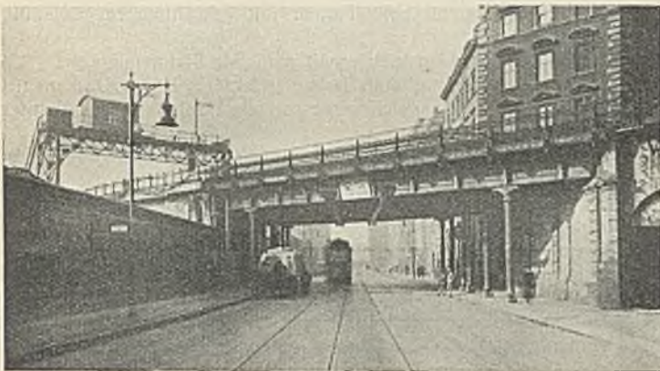
Abb. 1. Unterführung der Holzmarktstraße in Berlin. Alte Brücke.
