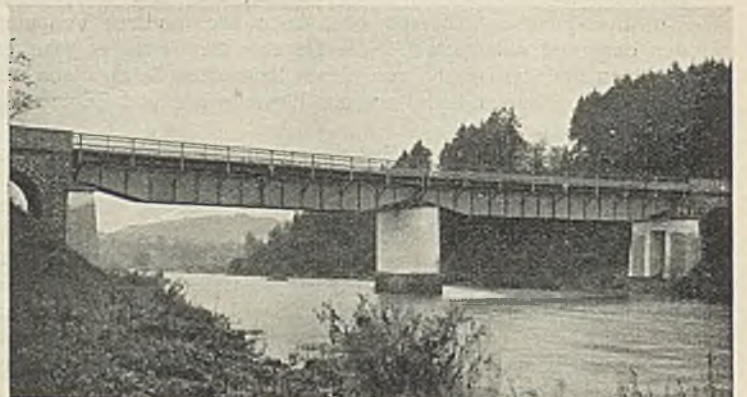
Abb. 6. Neue Brücke über die Sieg.
