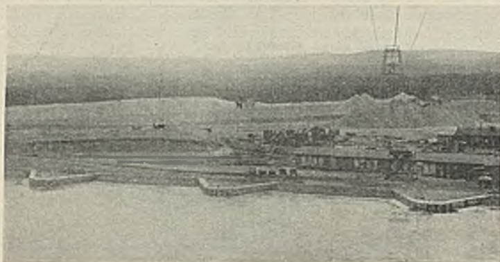
Abb. 11. Pfeiler im oberen Vorhafen.
