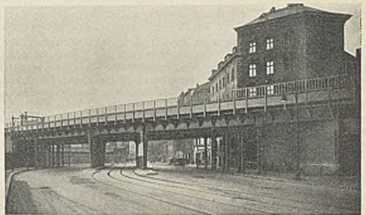
Abb. 2. Unterführung der Holzmarktstraße in Berlin. Neue Brücke.
