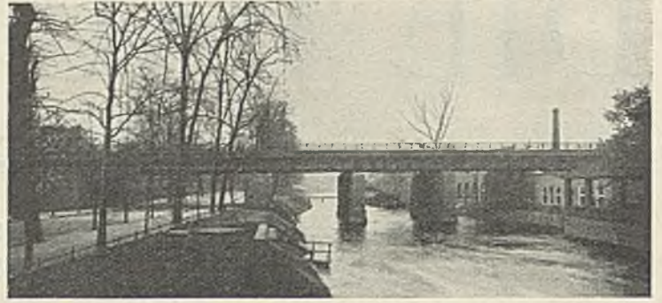
Abb. 4. Unterführung des Gartenufers und der Freiarche der Berliner Stadtbahn.
