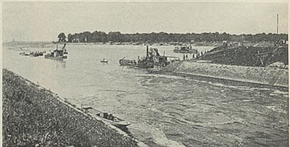
Abb. 12. Erweiterung des Unterhafens der Schleuse Ransern. Naßbaggerung.
