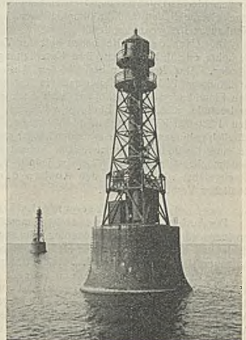
Abb. 2. Schifffahrtsstraße Swinemünde—Stettin: Hafftorfeuer Süd.
