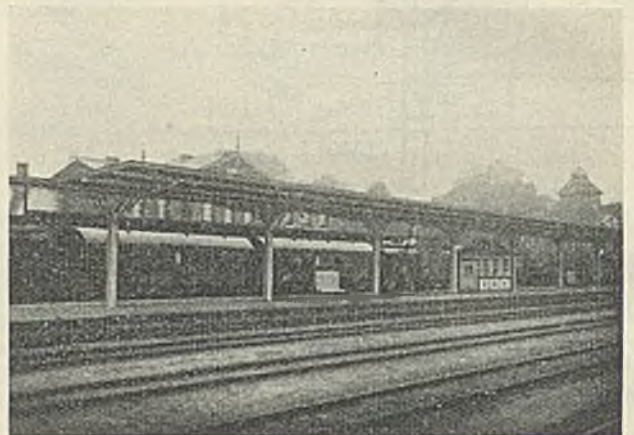
Abb. 6. Ansicht von Norden.
