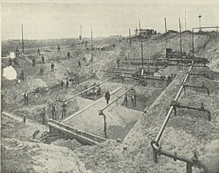
Abb. 7. Baugrube 8,50 m tief fertig ausgeschachtet bei 7 m Grundwasserabsenkung.
