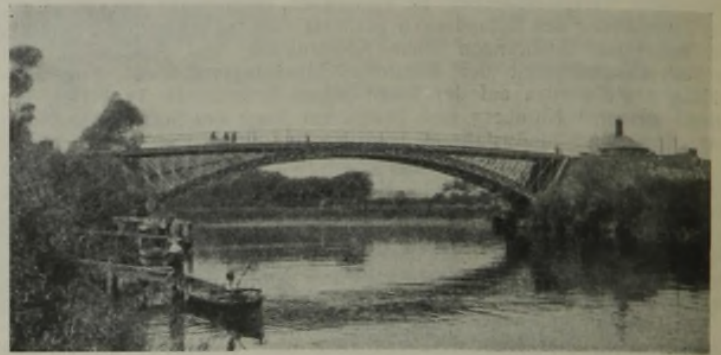
Abb. 1. Holt-Fleet-Brücke vor dem Umbau.
