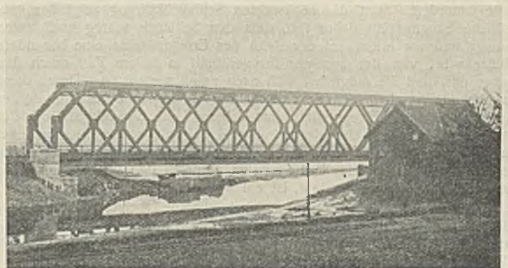
Abb. 26. Zweigleisige Eisenbahnbrücke über den Untergraben.
