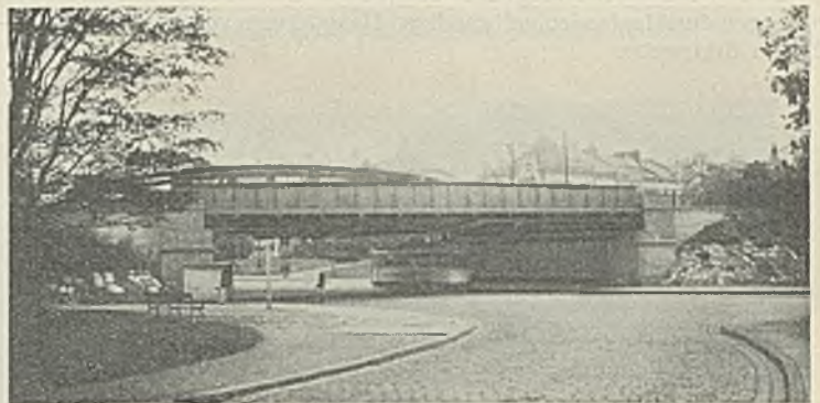
Abb. 10. Unterführung der Stephanitorstraße in Bremen. Neuer Überbau.
