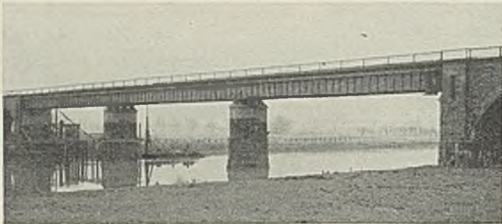
Abb. 15. Weserbrücke bei Fürstenberg.
