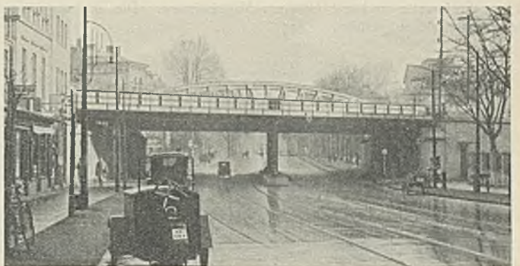
Abb. 12. Unterführung der Schwachhauser Heerstraße in Bremen. Neuer Überbau.
