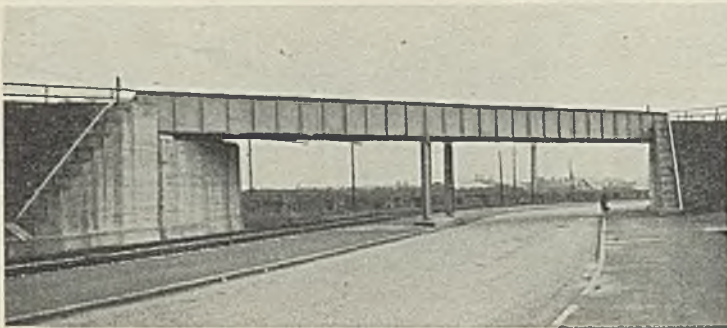
Abb. 16. Eingleisige Eisenbahnbrücke über die Straße von Untertürkheim nach Cannstatt.
