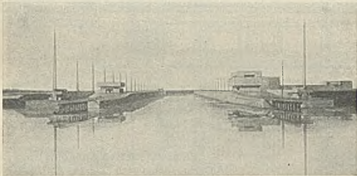
Abb. 1. Ansicht der Schleuse (Binnenhaupt).
