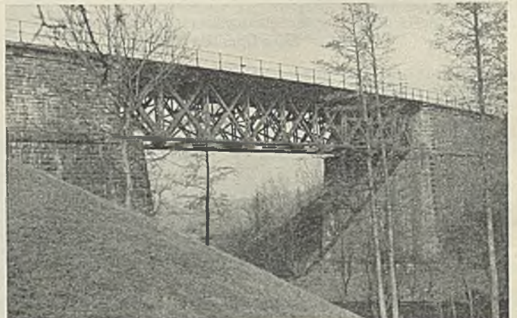
Abb. 19. Alte Elzbachbrücke bei Neckarelz.
