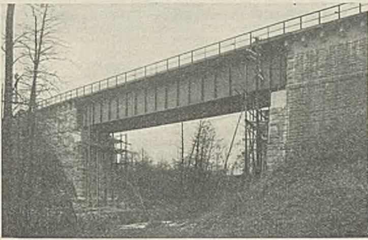
Abb. 20. Neue Elzbachbrücke bei Neckarelz.
