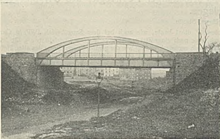
Abb. 23. Zweigleisige Eisenbahnbrücke über die Veronikastraße in Essen.
