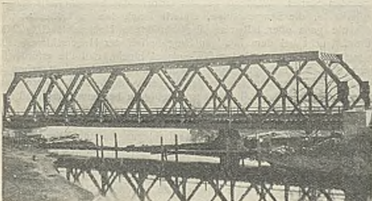
Abb. 25. Zweigleisige Eisenbahnbrücke über den Obergraben.
