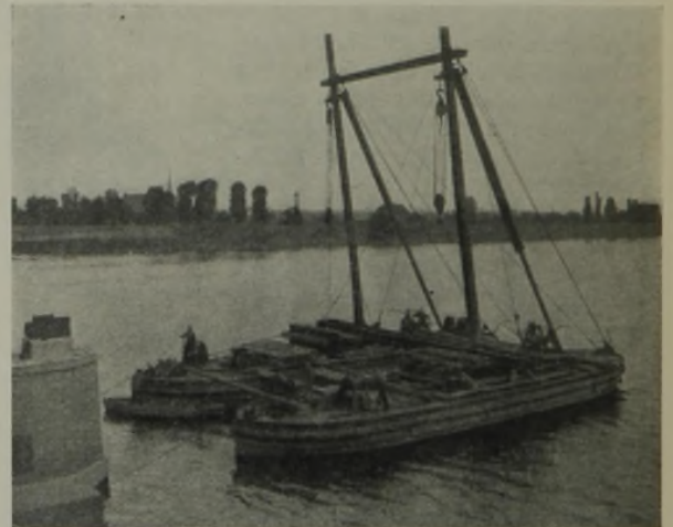
Abb. 40. Süderelbbrücke. Behelfsmäßiger Schwimmkran.
