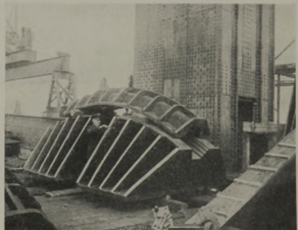
Abb. 89. Lagerteile für den Kabelsattel auf den Pylonenköpfen.
