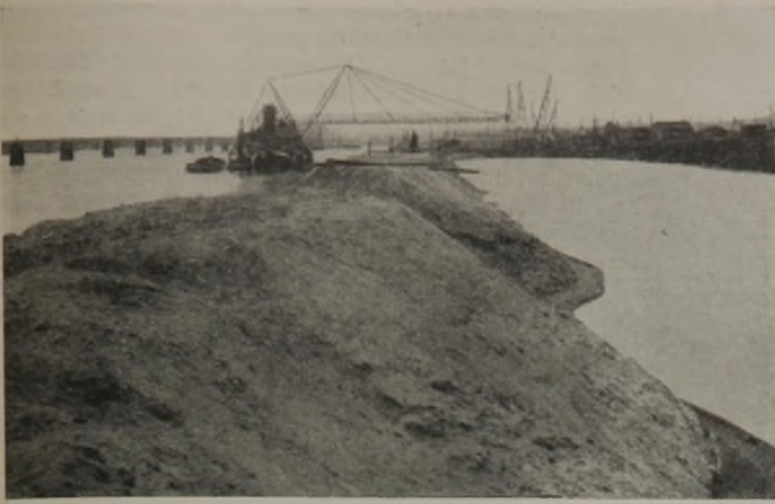
Abb. 28. Burchardkai — Ostteil. Endgültiger Schutzdamm aus Sand.
