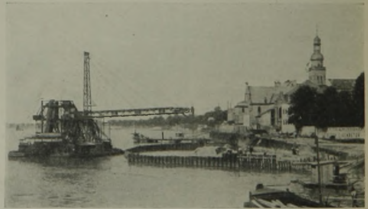
Abb. 15. Anschüttung des Senkkastenplanums für den rechten Pylonenpfeiler.
