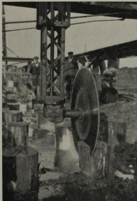
Abb. 13. Kappsäge beim lotrechten Schnitt.
