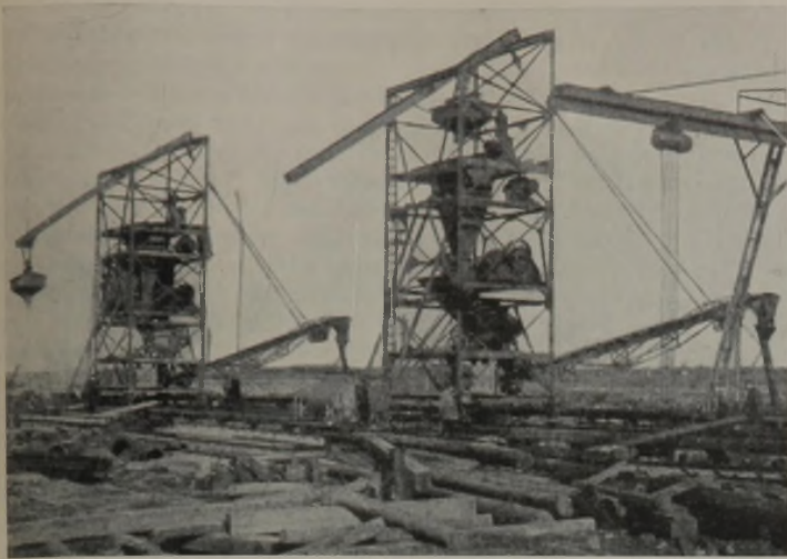
Abb. 18. Fahrbare Betonierungsanlagen.
