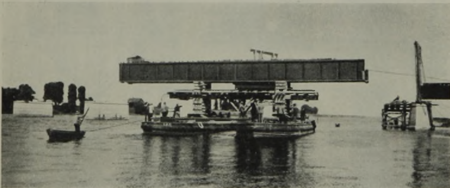
Abb. 39. Süderelbbrücke. Einbau eines Trägers der Wasseröffnungen.
