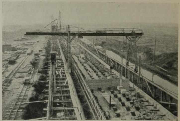
Abb. 15. Übersicht der Baustelle.
