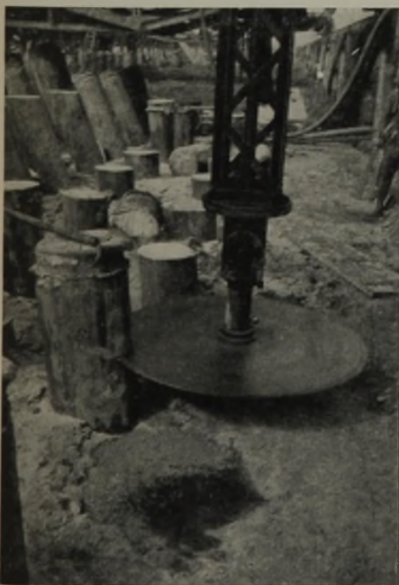
Abb. 12. Kappsäge beim waagerechten Schnitt.
