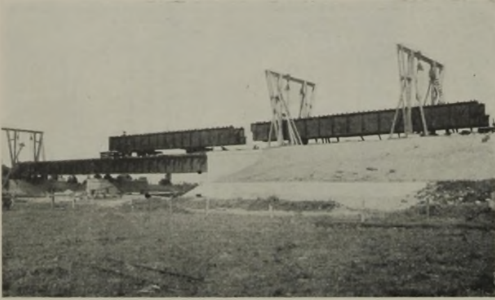
Abb. 37. Süderelbbrücke. Einbau der Träger über den Landöffnungen.
