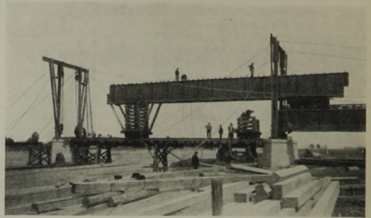
Abb. 38. Süderelbbrücke. Einbau des letzten Trägers über den Landöffnungen.
