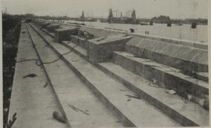
Abb. 32. Rückansicht der Kaimauer Burchardkai.
