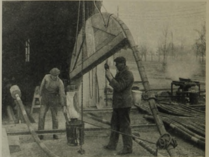
Abb. 78. Vorrichtung zur Vorbehandlung des Seilendes vor dem Vergießen des Seilkopfes.
