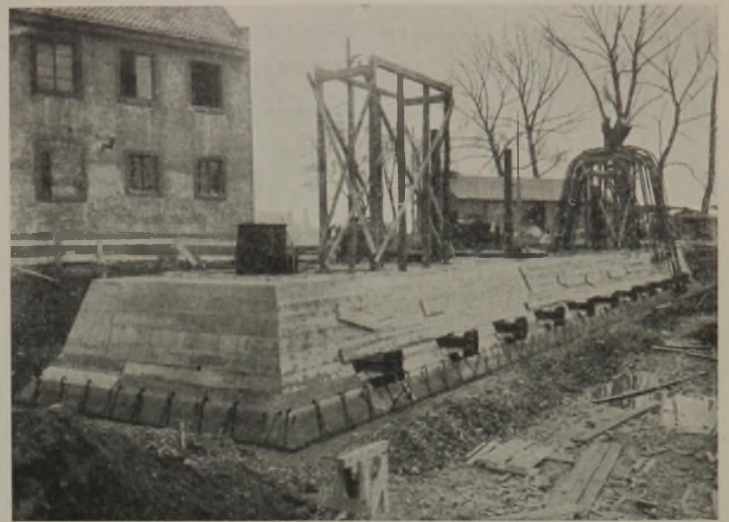
Abb. 24. Linker Ankerpfeiler; innere Senkkastenschalung mit dem Querbalken für den späteren Füllkörper des Arbeitsraumes.
