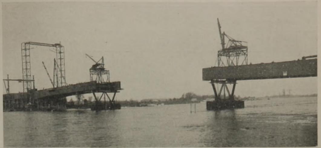
Abb. 101. Montagezustand nach Abbruch der Rüstungen in der Mittelöffnung.
