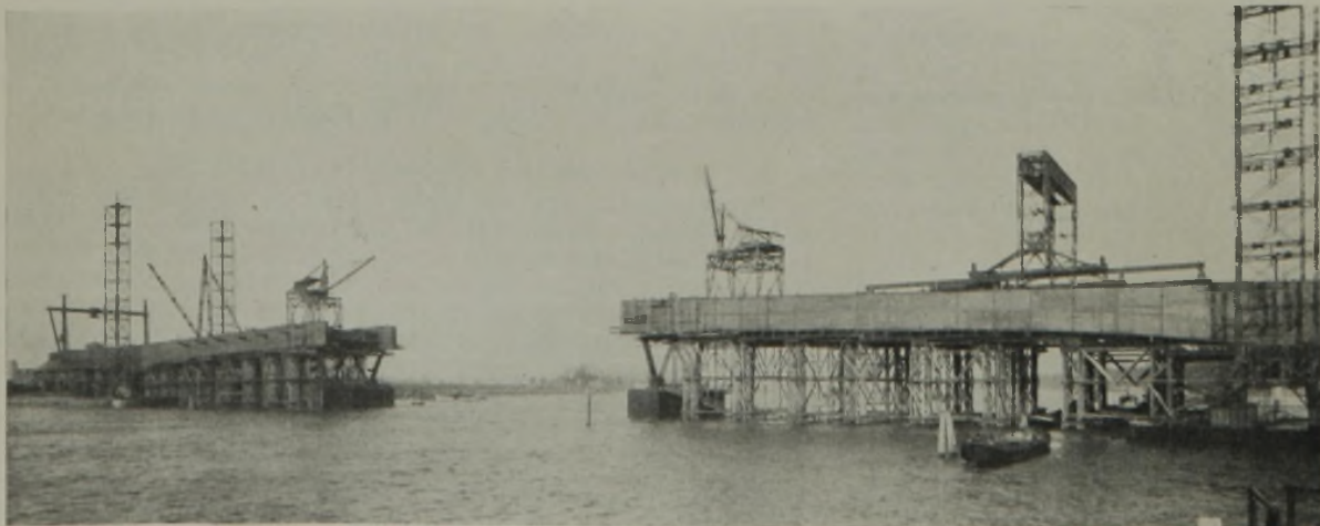
Abb. 100. Montagezustand am 7. November 1928.
