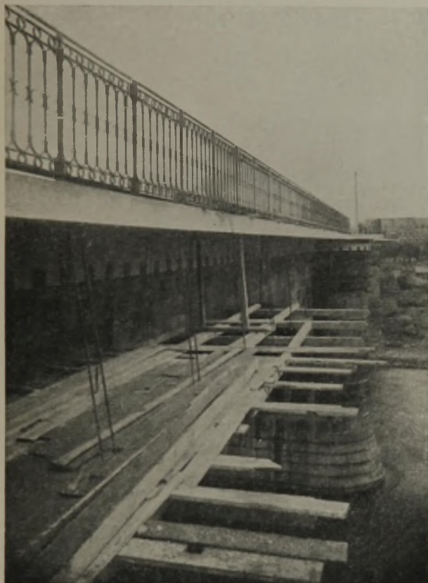
Abb. 16. Abbruch des Hängegerüsts.
