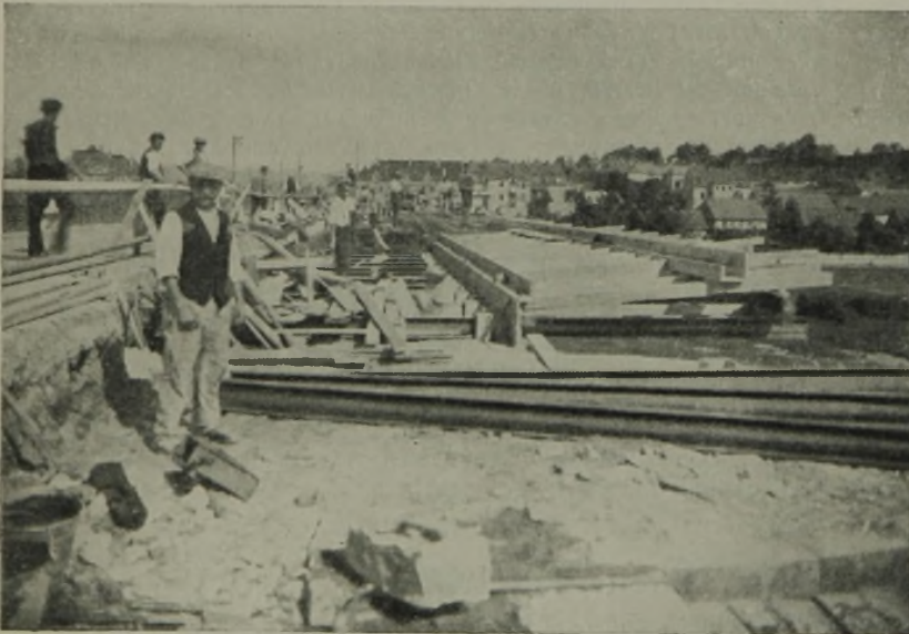
Abb. 14. Rüstung für die Schalung in den Stromöffnungen.
