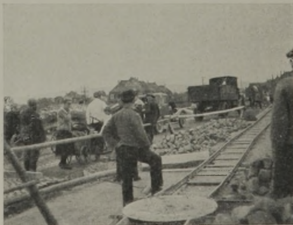
Abb. 12. Verkehrseinschnürung während der Bauarbeiten.
