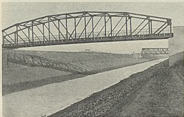
Abb. 19. Mittellandkanal. Fertige Kanalstrecke mit Feldweg- und Eisenbahnbrücke Peine—Braunschweig.
