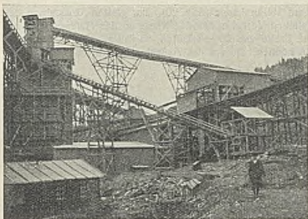
Abb. 18. Saaletalsperre am Bleiloch. Betonbereitungsanlage.
