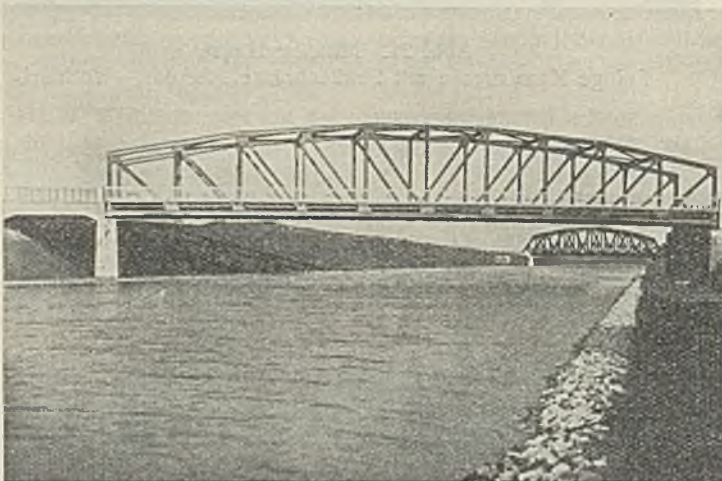
Abb. 26. Mittellandkanal. Straßenbrücke Wenderzelle—Völkenrode im Hintergrunde Eisenbahnbrücke Celle—Braunschweig.
