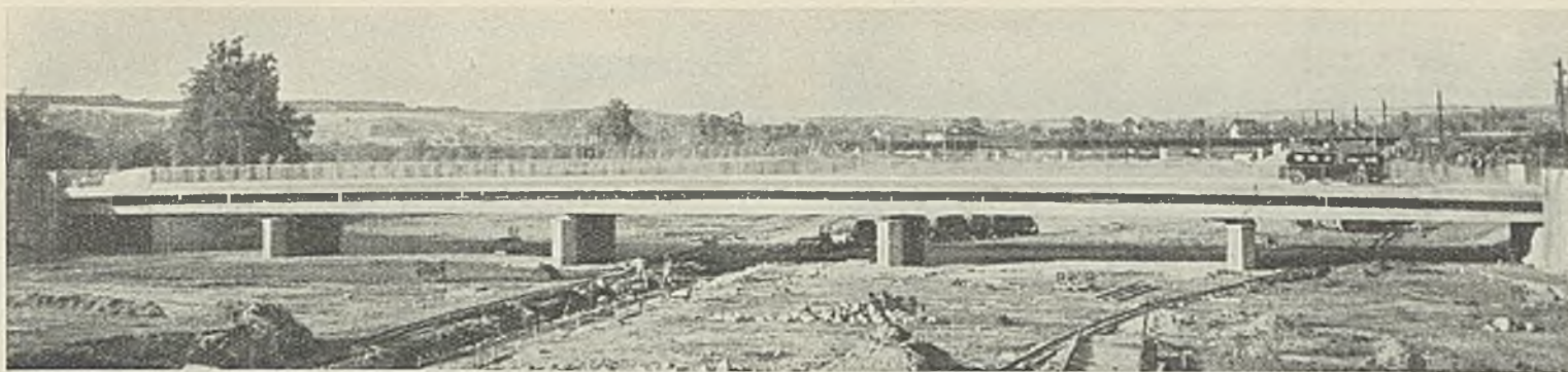
Abb. 5. Ansicht der Meeraner Brücke in Glauchau.
