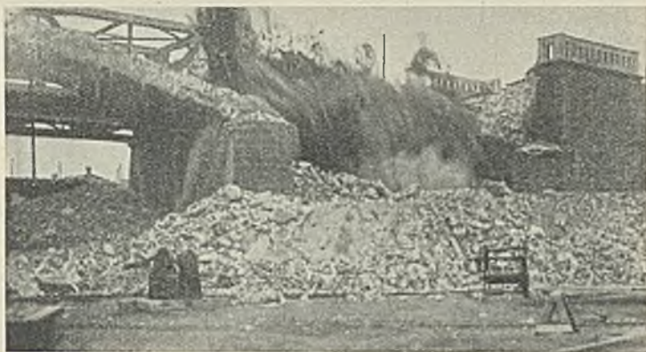
Abb. 22. Sprengen des letzten Ringes eines Gewölbes.
