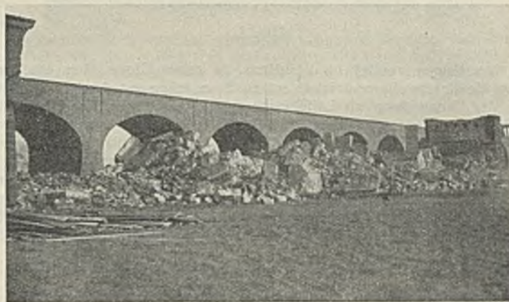
Abb. 23. Nach der Sprengung.
