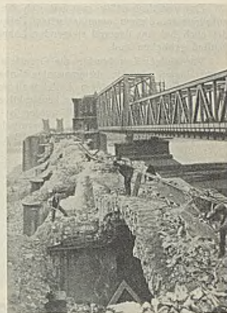
Abb. 21. Sprengen der Gewölbe in einzelnen Ringen.
