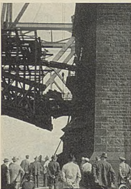
Abb. 10. Abtrennen des einen Endes des Überbaues.
