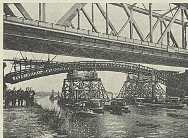
Abb. 9. Auspumpen der Schiffe.
