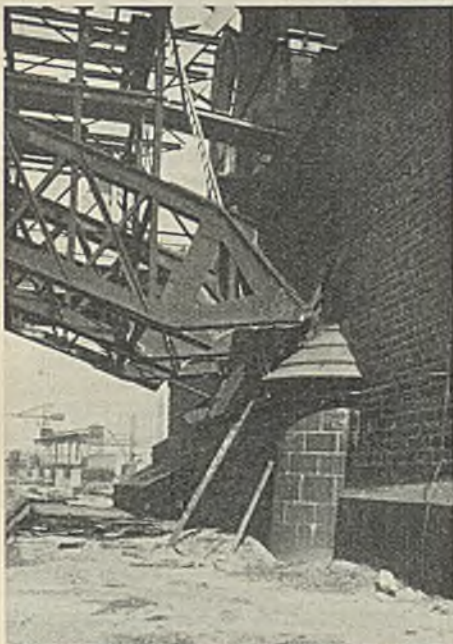
Abb. 3. Ein Stromüberbau für den Abtransport vorbereitet.
