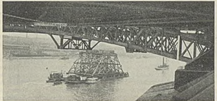
Abb. 4. Hilfsträger an einem Stromüberbau.
