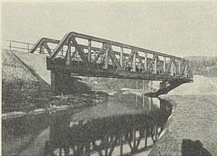
Abb. 33. Einleisige Eisenbahnbrücke über einen Kanal beim Bahnhof Thiergarten.
