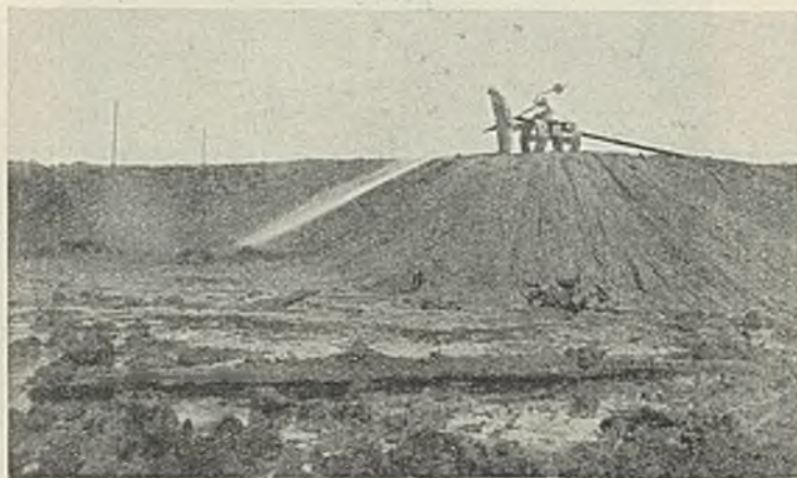
Abb. 34. Küstenkanal. Abspritzen des Moorbodens in Los 1.
