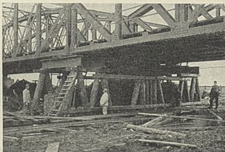
Abb. 22. Abbruch der alten Pfeiler.
