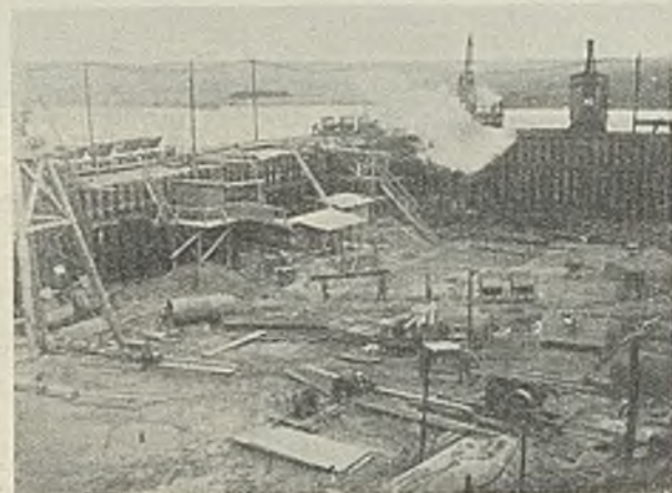
Abb. 32. Umbau des Weserwehres Dörverden. Blick in die Baugrube.
