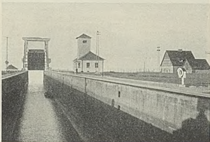
Abb. 40. Kanal Wesel—Datteln. Schleuse Dorsten.
