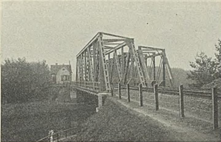
Abb. 29. Eingleisige Eisenbahnbrücke über den Elbe-Trave-Kanal.
