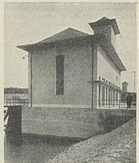
Abb. 41. Kanal Wesel—Datteln. Pumpwerkgebäude an Schleuse Ahsen.
