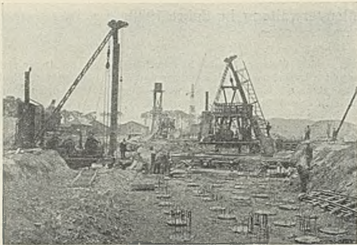
Abb. 33. Zweite Fahrt des Dortmund-Ems-Kanals bei Olfen. Gründung der Kanalüberführung bei Klauke.
