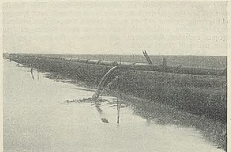
Abb. 36. Küstenkanal. Auslauf des Moorbodens ins Spülfeld.
