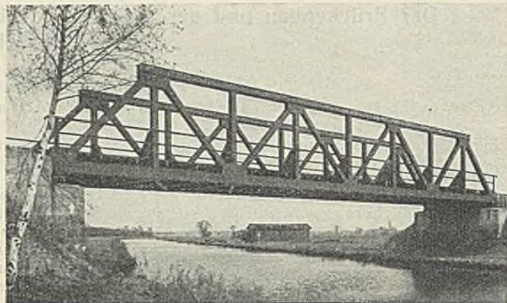
Abb. 35. Kanalbrücke bei Storkow.
