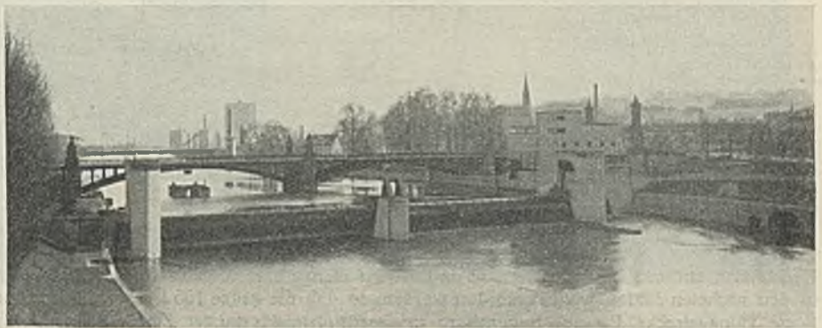
Abb. 49. Staustufe Cannstatt. Wehr und Kraftwerk (Unterwasserseite).
