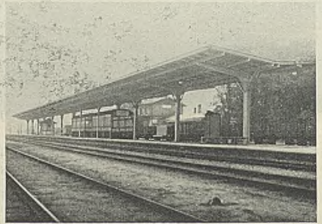
Abb. 54. Bahnsteigdach in Fürstenberg.
