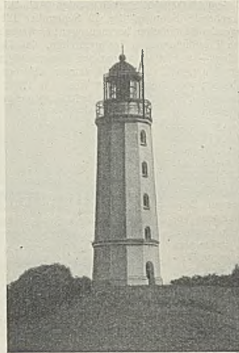
Abb. 12. Leuchtturm nach Beendigung sämtlicher Arbeiten.
