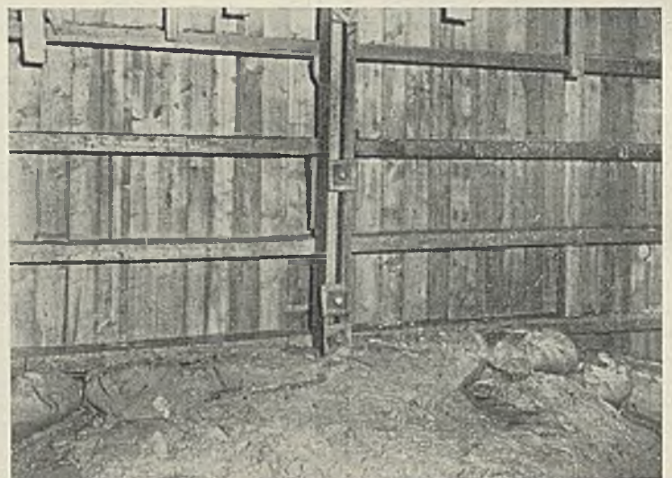
Abb. 17. Sandsackdichtung an der Pfeilerschalung nach dem Leerpumpen der Baugrube.
