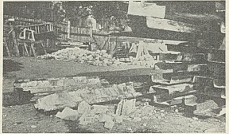
Abb. 25. Der ausgespülte Zement hat sich in den Wellen der eisernen, später abgeschnittenen und ausgezogenen Spundbohlen abgesetzt; ein Teil der Bohlen ist bereits gereinigt.
