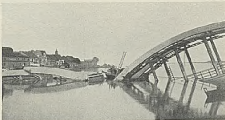
Abb. 6. Links der zerstörte Mittelbogen, rechts der schräg im Wasser liegende wiesenseitige Bogen.
