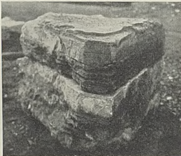
Abb. 19. Block aus dem stadtseitigen Strompfeiler (Pfeilerspitze stromaufwärts), rd. 5,0 m unter Mittelwasser.
