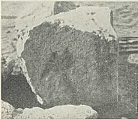
Abb. 14. Block aus dem stadtseitigen Strompfeiler, rd. 2,7 m unter Mittelwasser.
