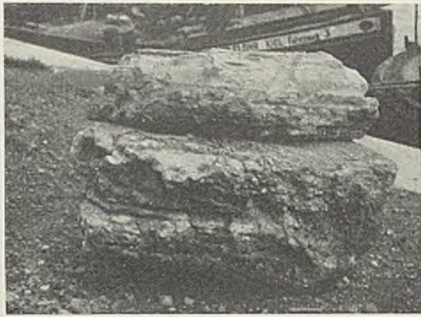
Abb. 21. Block vom unteren Ende des abgebrochenen Pfeilerschaftes des wiesenseitigen Strompfeilers.
