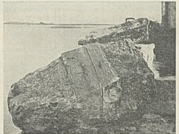
Abb. 28. Beton und Zementmasse aus dem Raum innerhalb des Schalungsmantels des aufgehenden Pfeilermauerwerks.
