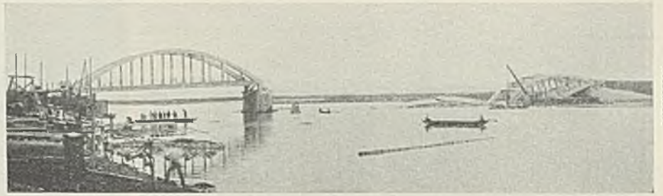
Abb. 4. Die Gartzter Wirtschaftsbrücke nach dem Einsturz.
