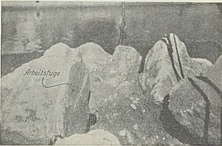
Abb. 13. Blöcke aus dem stadtseitigen Strompfeiler, etwa 1,5 bis 2,5 m unter Mittelwasser.
