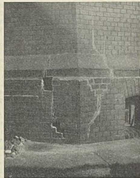
Abb. 5. Probelöcher unterhalb des Sockelgesimses.
