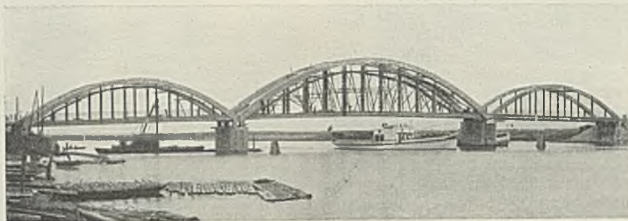
Abb. 1. Die Gartz Wirtschaftsbrücke wenige Tage vor dem Einsturz.
