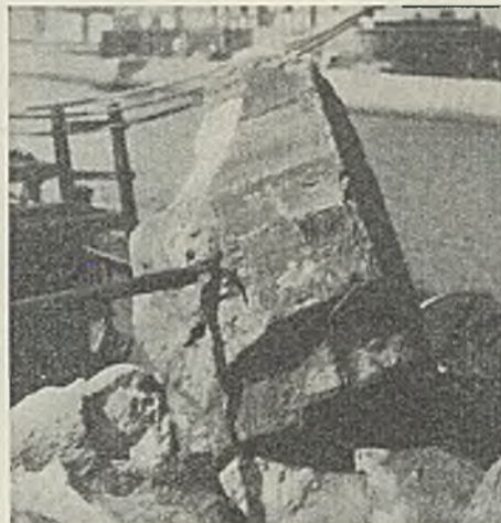
Abb. 15. Block aus dem stadtseitigen Strompfeiler, rd. 2,7 m unter Mittelwasser (Pfeilerspitze stromaufwärts).
