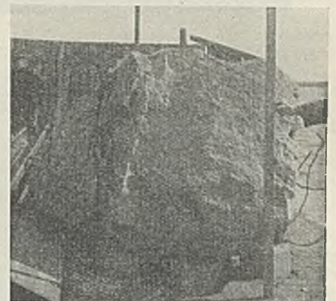
Abb. 17. Block aus dem wiesenseitigen Strompfeiler, rd. 1,0 m unter Mittelwasser.
