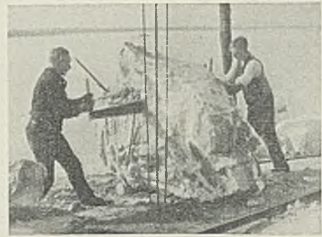
Abb. 27. Ein Block ausgespülten Zementes wird innerhalb von zwei Stunden mit der Schrotsäge durchgeschnitten.
