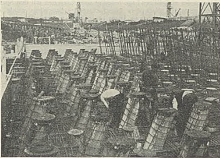
Abb. 21. Kajemauern, Bewehrung der Rostplatte.
