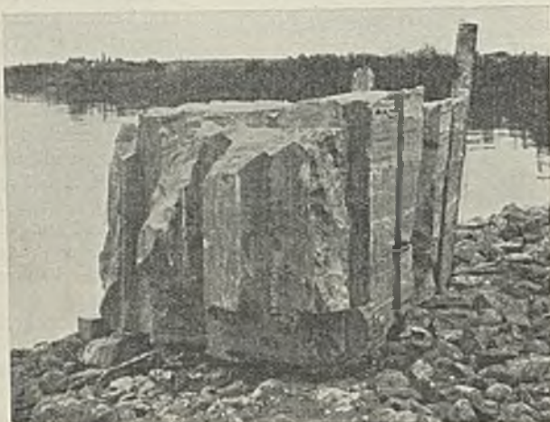
Abb. 26. Zwei Blöcke von ausgespültem Zement, der sich etwa 6 m unter Mittelwasser zwischen dem Schalungsmantel des aufgehenden Pfeilers und dem Spundwandkasten angesammelt hat (eingestürzter Pfeiler).
