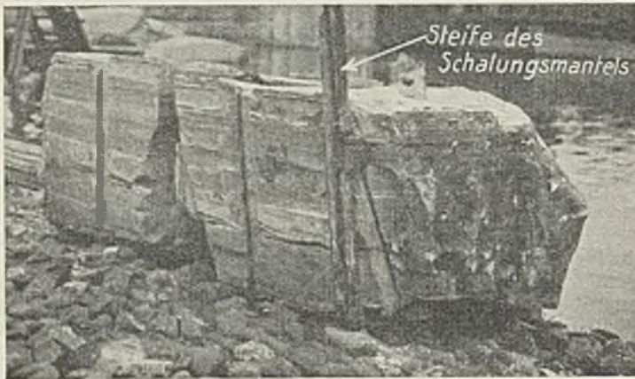
Abb. 25. Der ausgespülte Zement hat sich in den Wellen der eisernen, später abgeschnittenen und ausgezogenen Spundbohlen abgesetzt; ein Teil der Bohlen ist bereits gereinigt.
