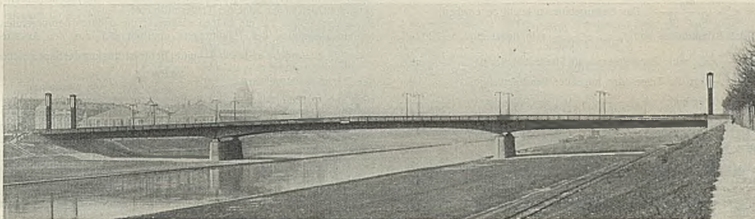
Abb. 3. Ebertbrücke Mannheim (M. A. N.).
