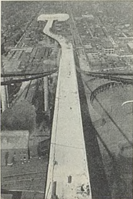
Abb. 18. Blick von der Spitze des amerikanischen Hauptturms auf die Stadt Detroit. Das Abschwenken des Brückenendes wurde notwendig, weil bei einer geraden Führung sehr wertvolles bebautes Gelände zum Opfer gefallen wäre.
