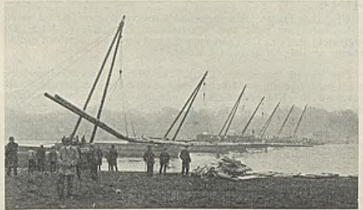
Abb. 11. Beendigung des Einschwimmens.
