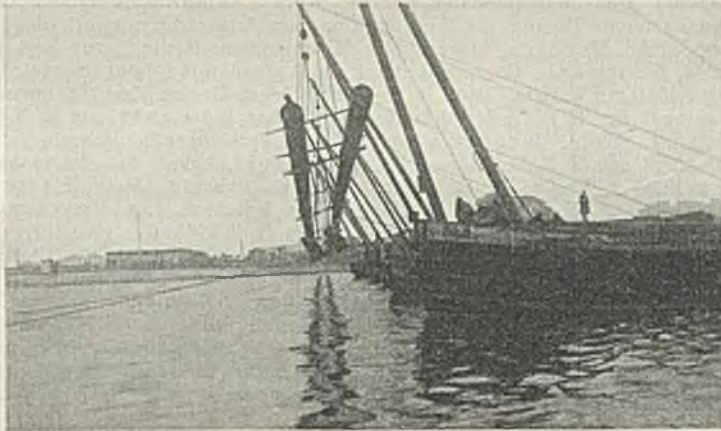
Abb. 10. Die Leitung wird eingeschwommen.
