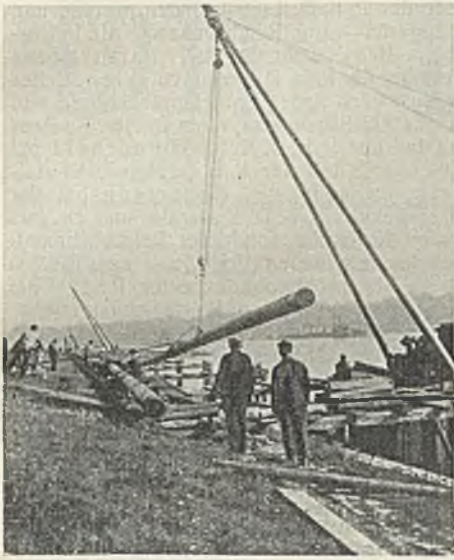
Abb. 8. Montage des einzuschwimmenden Leitungsteiles am linken Ufer.
