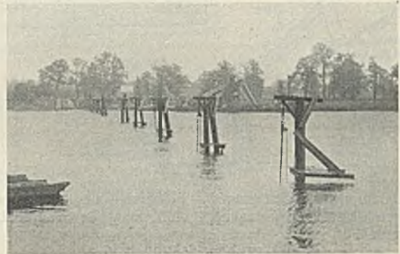
Abb. 6. Abgesenkte Leitung.
