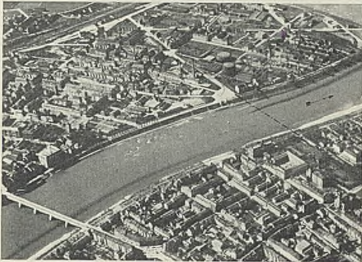
Abb. 1. Fliegeraufnahme von der Lage der geplanten Brücke.
