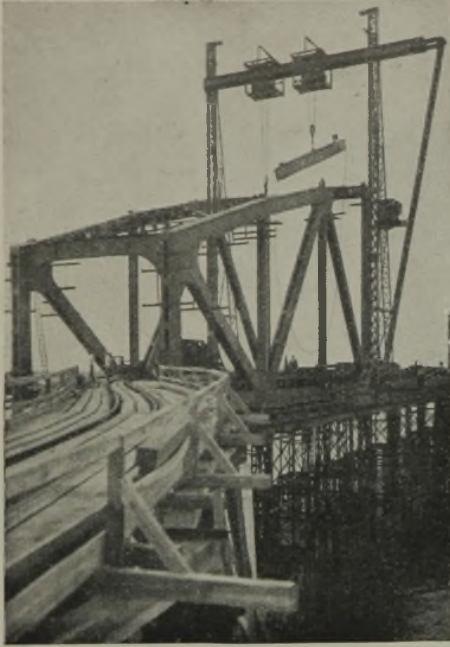
Abb. 6. Arbeiten mit dem Montierungskran.
