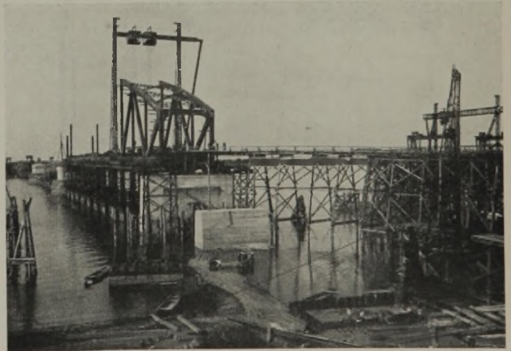
Abb. 5. Montage des ersten Überbaues der Strombrücke. Stand der Arbeiten am 21. August 1929.
