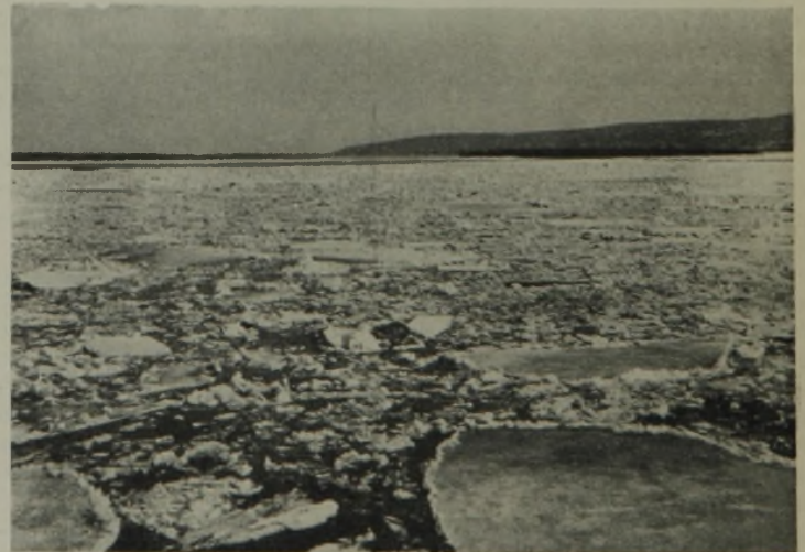
Abb. 1. Eisgang an der Baustelle. Aufnahme vom 17. März 1929.
