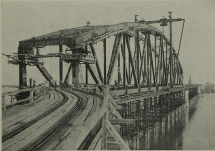
Abb. 7. Montage des ersten Überbaues der Strombrücke. Stand der Arbeiten am 6. September 1929.
