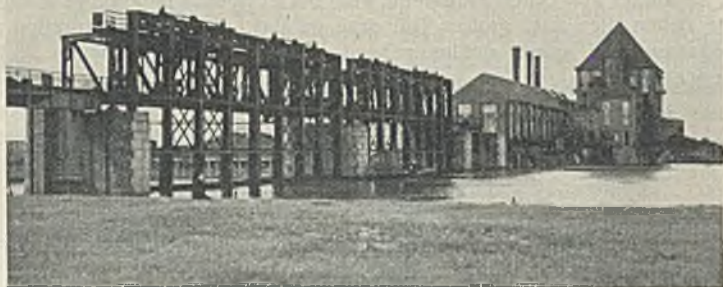
Abb. 1. Das alte Wehr.
