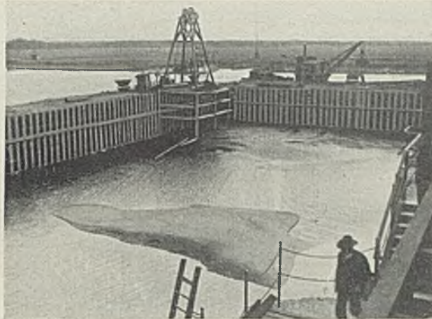
Abb. 20. Fertiger Fangedamm und Leerpumpen der Baugrube.
