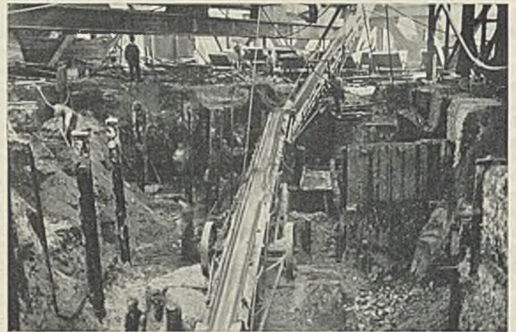
Abb. 26. Bodenaushub für die Baugrube des Pfeilers G .
