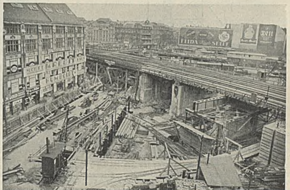
Abb. 22. Ansicht der Baustelle von der Alexanderstraße aus.
