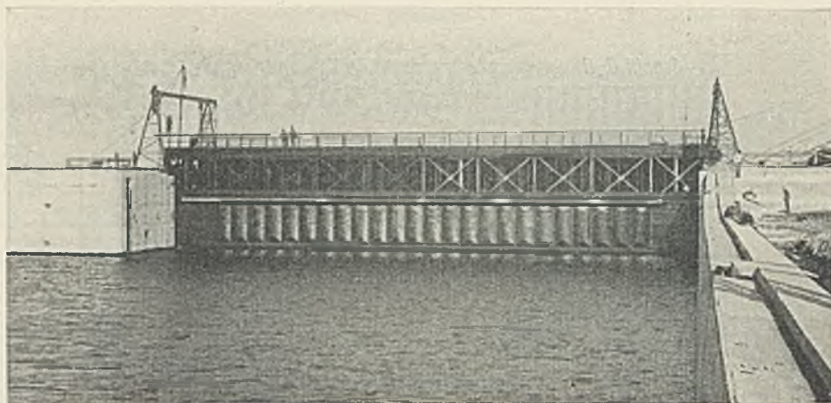
Abb. 15. Tor Außenhaupt Außenseite schwimmend, mit den Absenkböcken.
