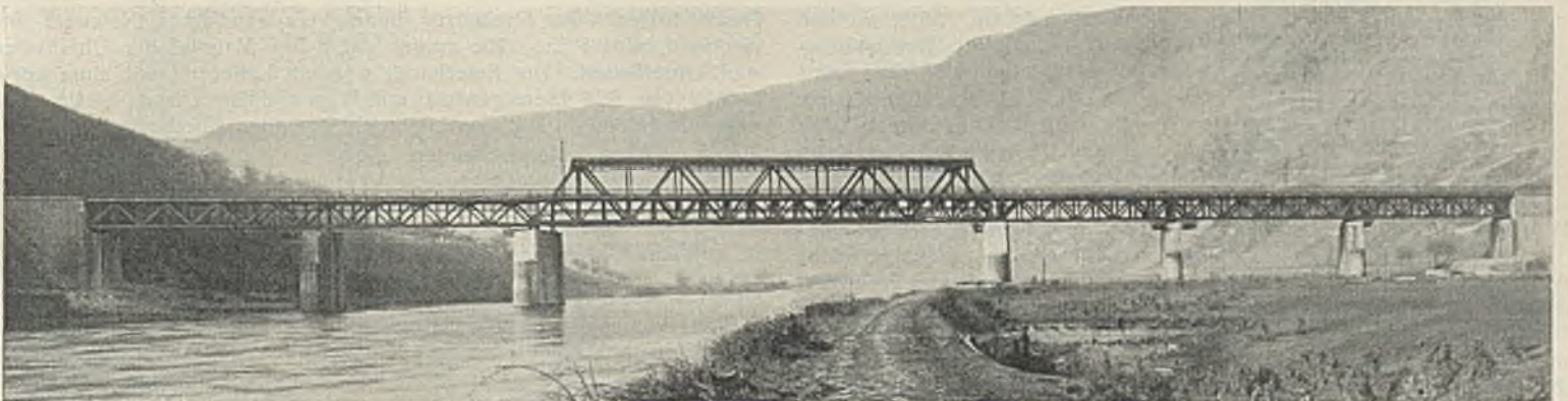
Abb. 3. Moselbrücke bei Eller nach dem Umbau.
