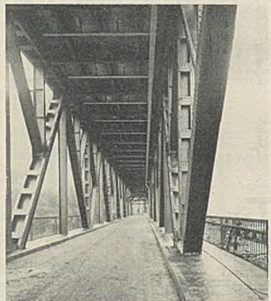
Abb. 16. Moselbrücke Bullay. Innenansicht.
