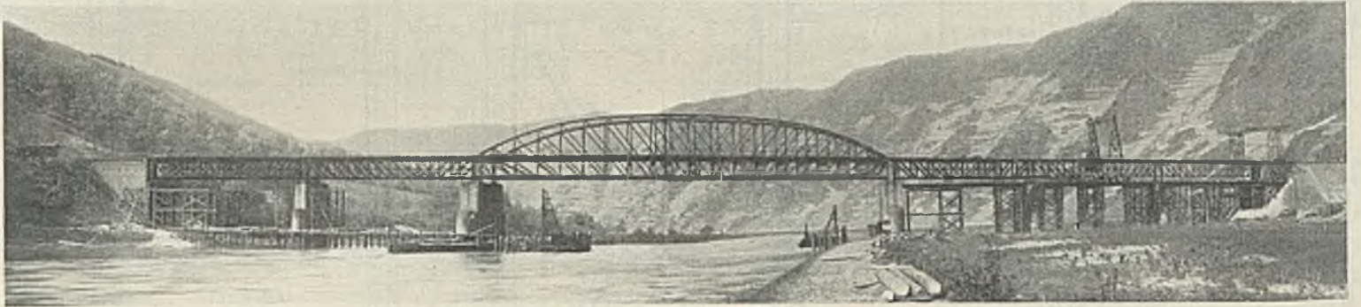
Abb. 1. Moselbrücke bei Eller vor dem Umbau.
