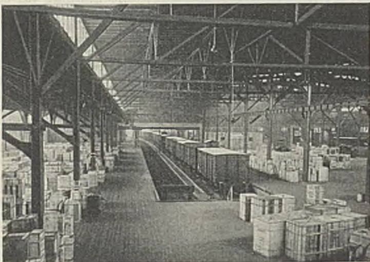
Abb. 5. Innenansicht des Schuppens (Ostteil).
