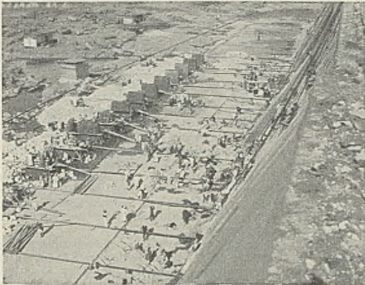
Abb. 3. Gründung der Strebepfeiler des östlichen Bauabschnittes.
