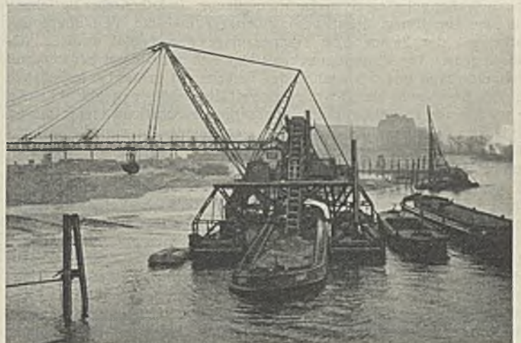
Abb. 6. Aufhöhung des Geländes mit Schutentleerer.
