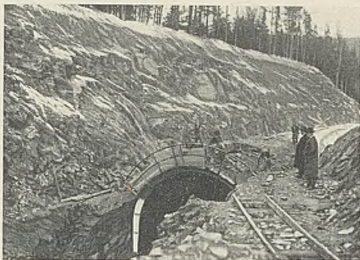
Abb. 9. Abbruch des Tunnelgewölbes.
