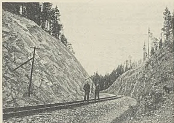
Abb. 10. Fertiggestellter Einschnitt (etwa früheres Ostportal).
