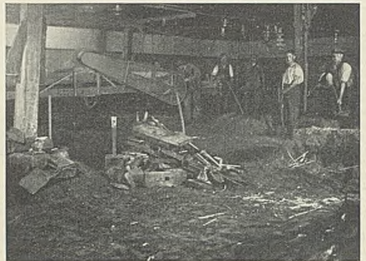
Abb. 10. Inneres der Arbeitskammer des Senkkastens.
