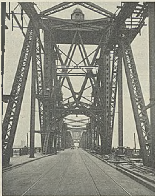
Abb. 7. Einbau der neuen Verstärkungsbleche in die Pfosten der großen Pylonen.
