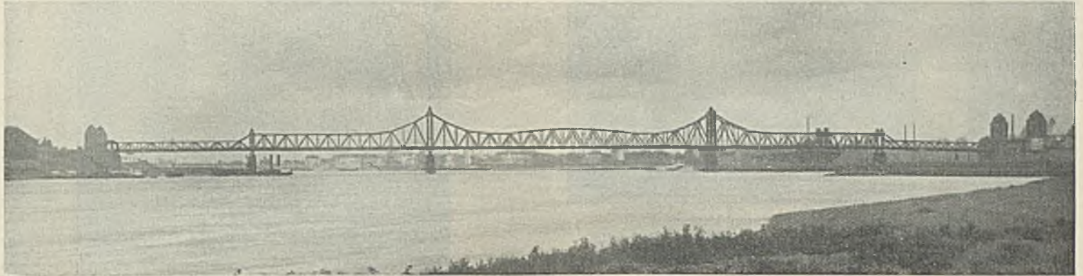
Abb. 1. Gesamtansicht der Brücke.
