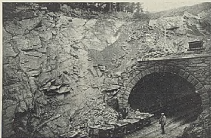
Abb. 3. Ostportal mit am 8. 10. 1929 abgerutschten Massen.
