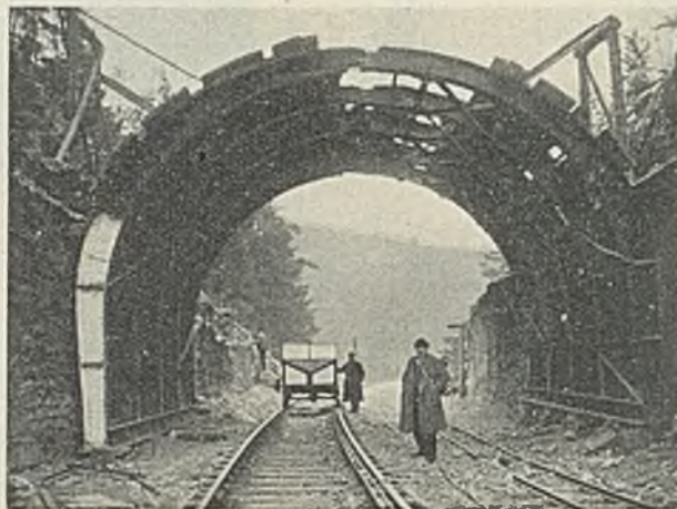
Abb. 7. Lehrgerüst nach Abbruch des Tunnelgerüsts.
