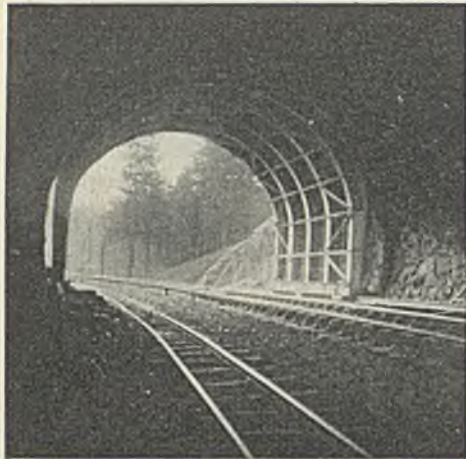
Abb. 6. In den Tunnel eingefahrenes Lehrgerüst.
