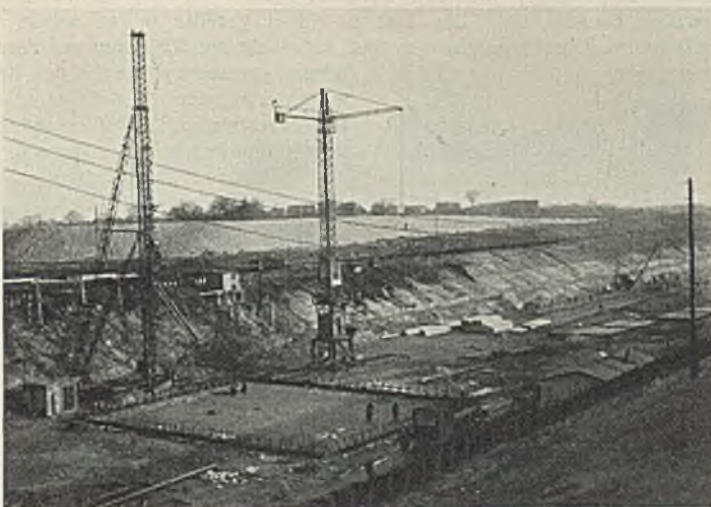
Abb. 6. Blick auf die Schleusenbaugrube mit ausgelegter Senkkastenschneide für das Unterhaupt.
