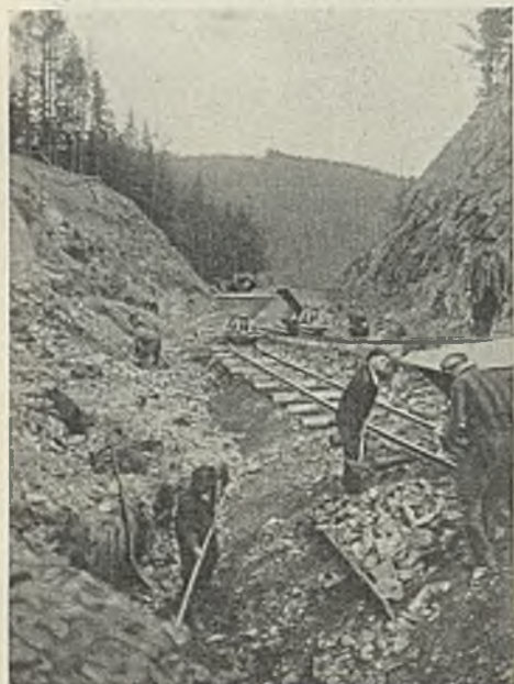
Abb. 8. Abbau der Massen in den Gewölbezwickeln.
