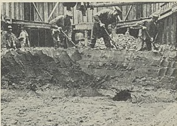
Abb. 8. Übergang der Klei- in die Sandschicht.
