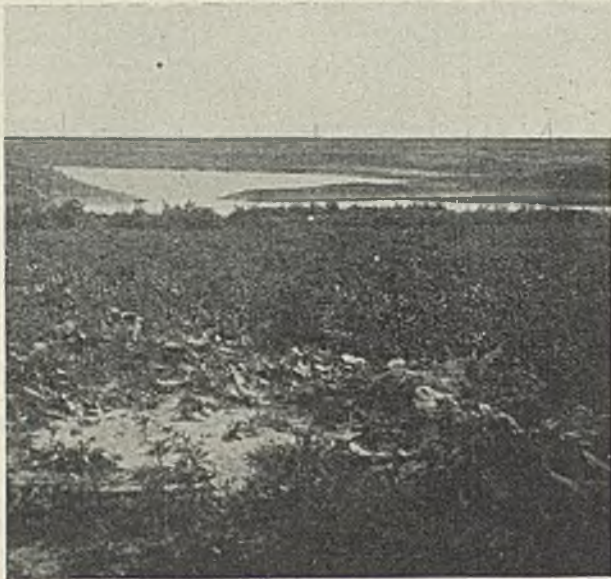
Abb. 18. Blick auf das Baugelände 1927.
