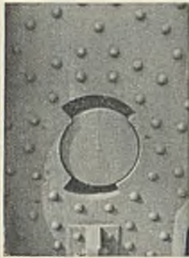
Zu Abb. 22. b) Unterer Bolzen der Hängependel nach Einbau der Stahlsegmente.
