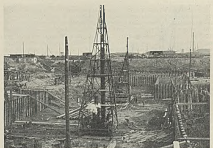
Abb. 12. Rammung der Querspundwände im Außenhaupt.
