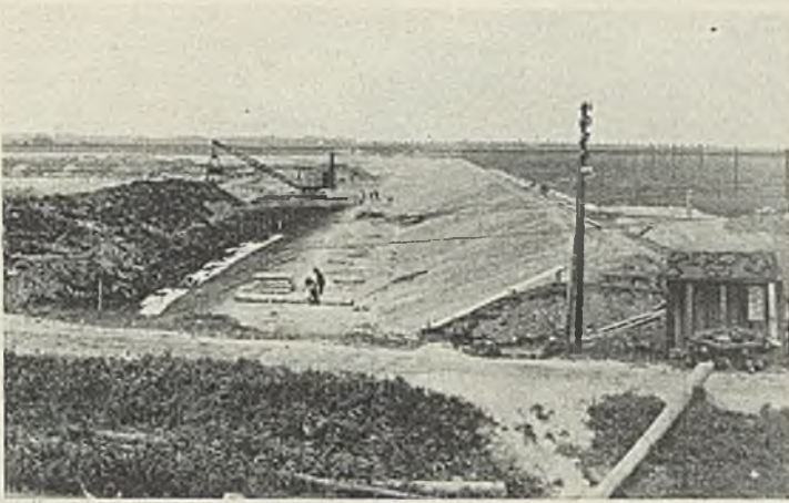
Abb. 10. Herstellung des Wendebeckendeiches.
