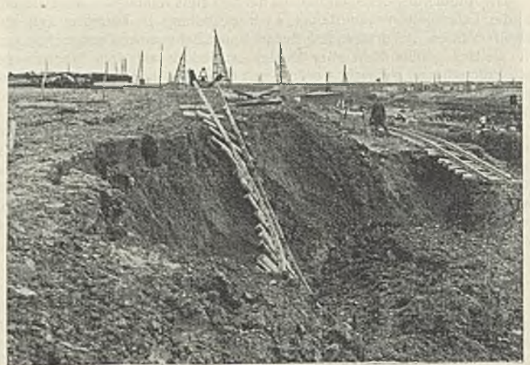
Abb. 9. Kippenrutschung bei nassem Wetter.
