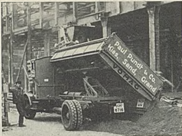
Abb. 4. 5-t-Pritschenwagen mit hydr. Eva-Wood-Dreiseitenkippvorrichtung. Vogtländische Maschinenfabrik AG., Plauen i. V.
