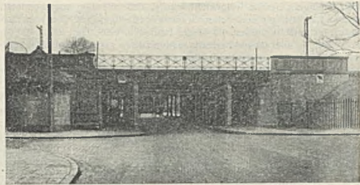
Abb. 11. Ansicht nach Fertigstellung.
