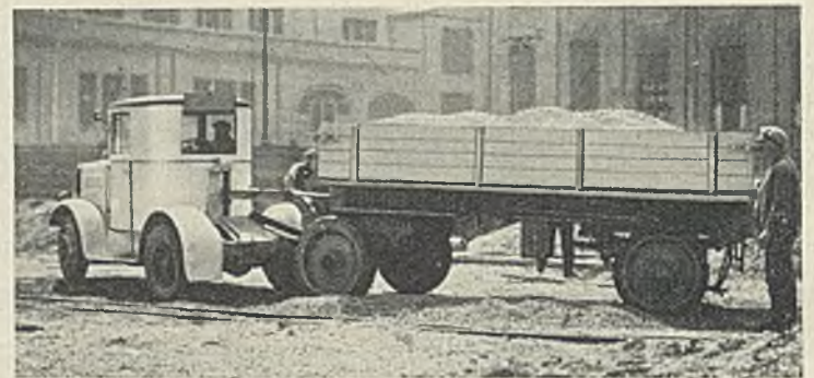
Abb. 7. 7,5-t-Anhänger AW 8 an Schnellzugwagen. I. A. Maffei AG., München.
