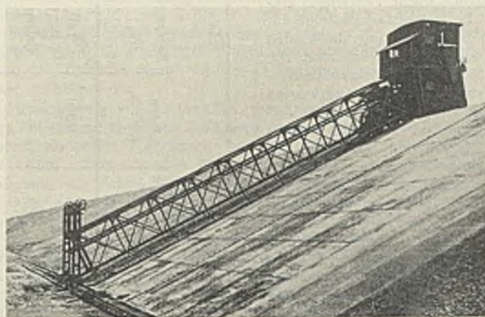
Abb. 2. Böschungsbetoniermaschine beim Bau des Rheinkanals Basel—Straßburg (Kraftwerk Kembs).
