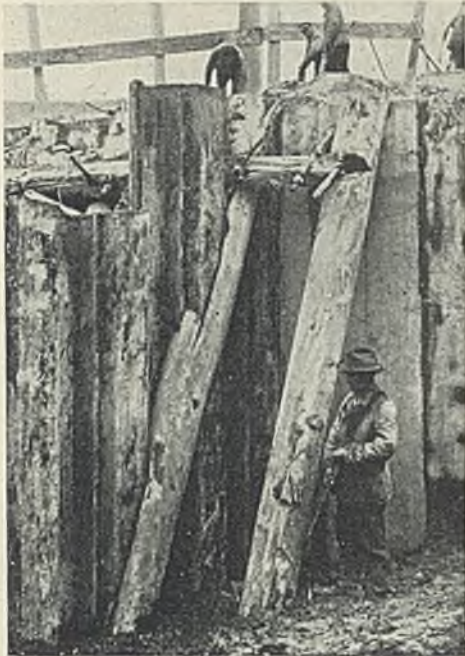
Abb. 22. Durchrammte Schrägpfähle.
