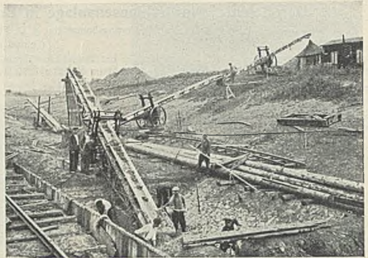
Abb. 20. Bodenaushub mit Hilfe von Förderbändern.
