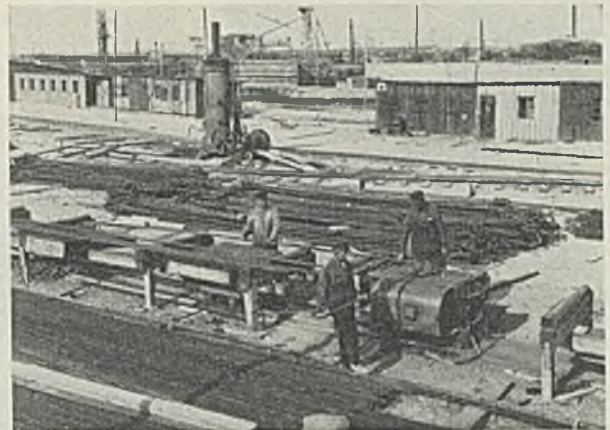
Abb. 7. Eisenbiegeplatz am Lager I.
