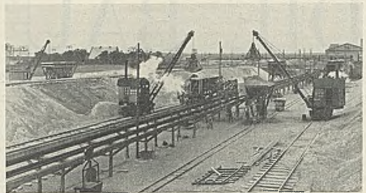
Abb. 3. Kiesverladeeinrichtung mit Hängebahn.
