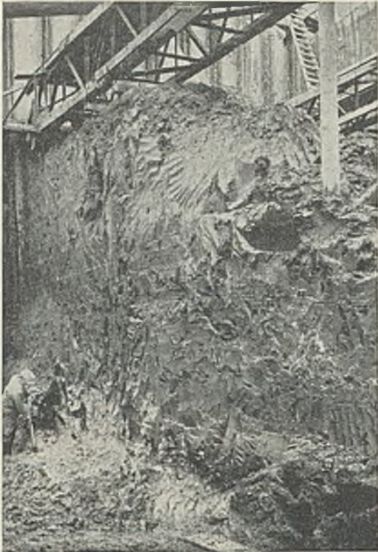
Abb. 22. Verlängerung des Kaiserdocks II, Bodenaushub unterhalb der Gitterträger.
