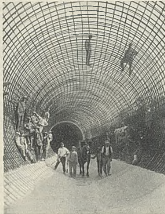
Abb. 18. Eisenbetondruckrohr Drac-Romanche: 6,0 l. W., 1,75 at.
