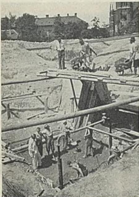
Abb. 10. Hauptträger-Fundament.
