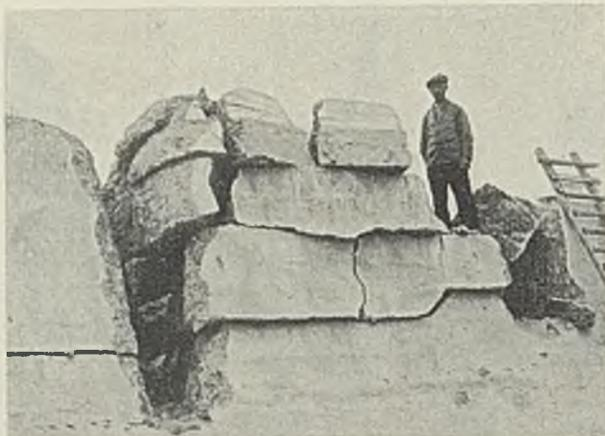
Abb. 31. Absprengen des Mauerblocks der alten Stirnmauer des Kaiserdocks II mittels Druckwasserpressen.
