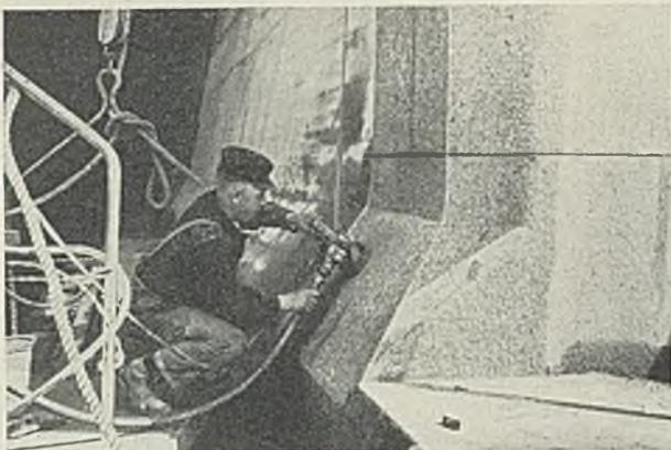
Abb. 26. Abschleifen der Toranschlagflächen auf der Granitverkleidung der Häupter.
