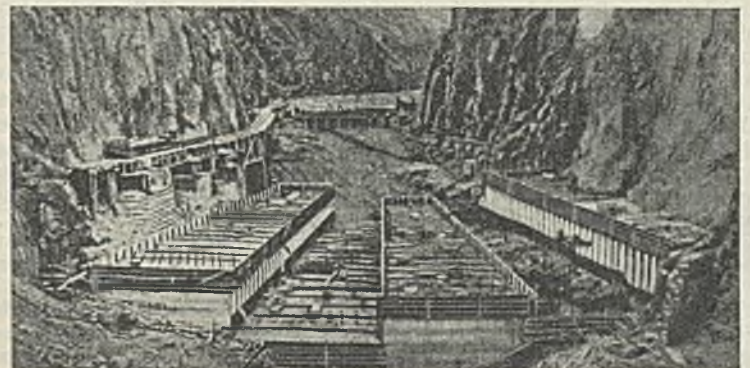
Abb. 2. Baustelle. Beginn des Betonierens.
