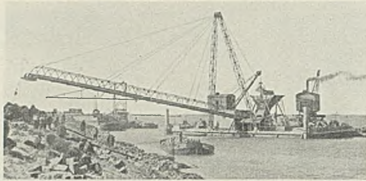
Abb. 5. Aufbringen von Keileem auf den Deich mit Gurtförderer.
