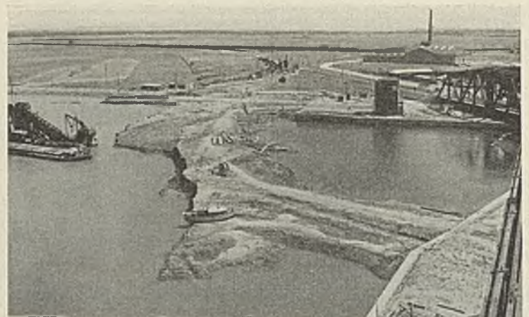
Abb. 8. Sperrdamm zwischen Wendebassin und Binnenhafen.
