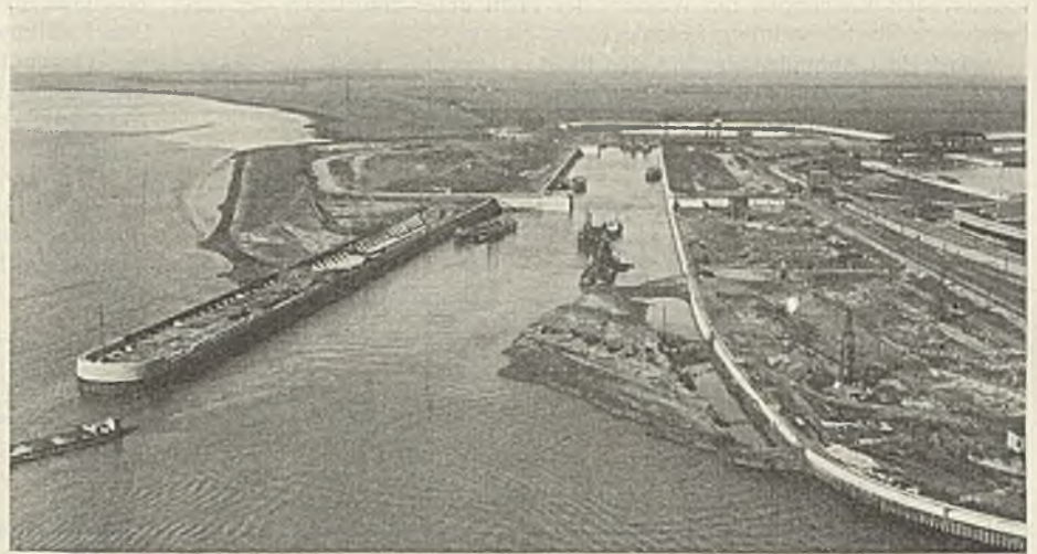
Abb. 7. Baggerung im Vorhafen und Wendebecken.
