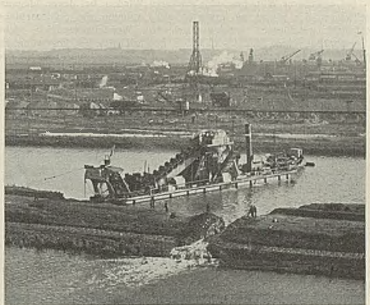
Abb. 4. Durchbaggerung des Straßendamms.
