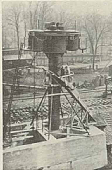
Abb. 16. Senkkasten des rechten Widerlagers mit Luftschleuse kurz nach Beginn des Absenkens.
