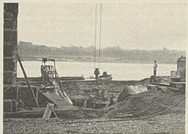
Abb. 11. Abbruch des alten Widerlagers am linken Stromufer und Herstellen der Arbeitsebene für den Senkkasten.
