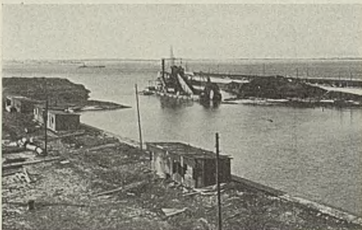
Abb. 6. Durchstich des Seedeiches.
