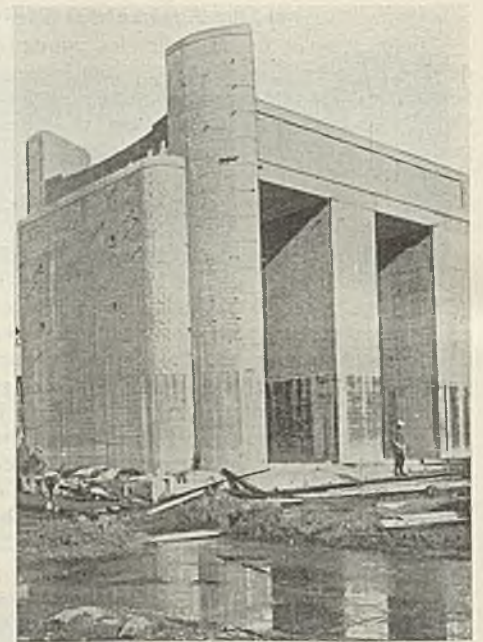
Abb. 18. Widerlager der Drehbrücke auf Kornwerdersand.
