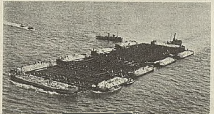
Abb. 30. Senkstück kurz vor dem Versenken.
