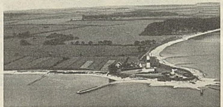
Abb. 14. Strand beim Auslaufbauwerk.
