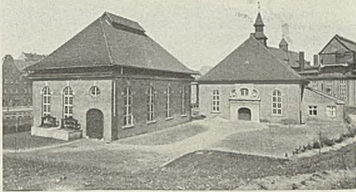
Abb. 3. Gebäude der Hauptpumpstation.
