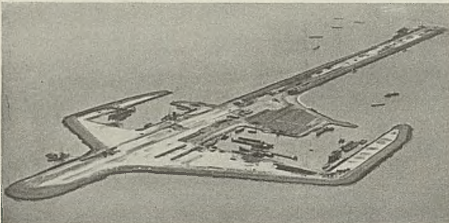
Abb. 26. Baustelle auf Breesand. November 1929.
