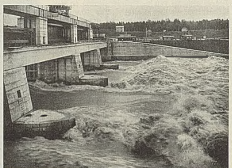
Abb. 7. Stauwehr. Ansicht vom Unterwasser (Nordufer).
