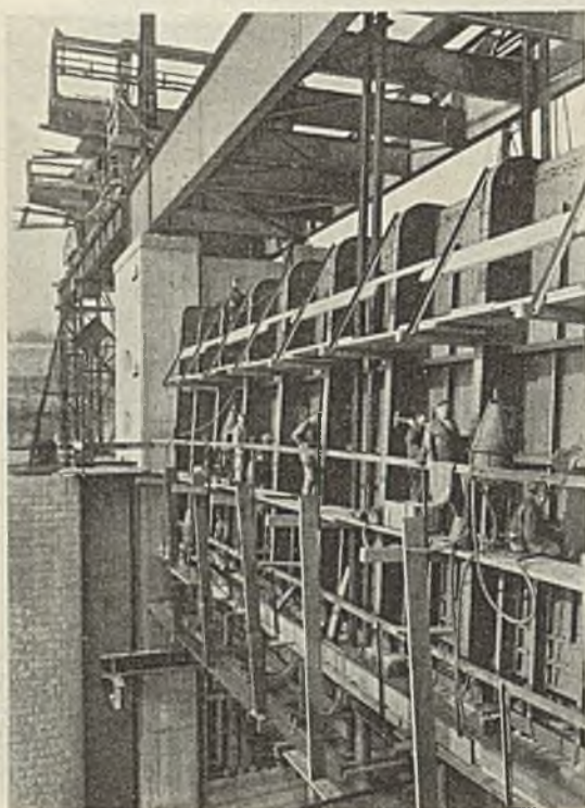
Abb. 11. Obere Schütze. Ansicht vom Oberwasser.
