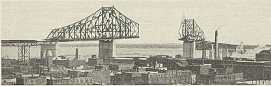
Abb. 5. Brücke im Bau.
