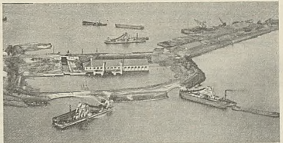
Abb. 39. Beseitigung des Ringdeiches am Pumpwerk bei Den Oever. Links die Schiffahrtsschleuse.
