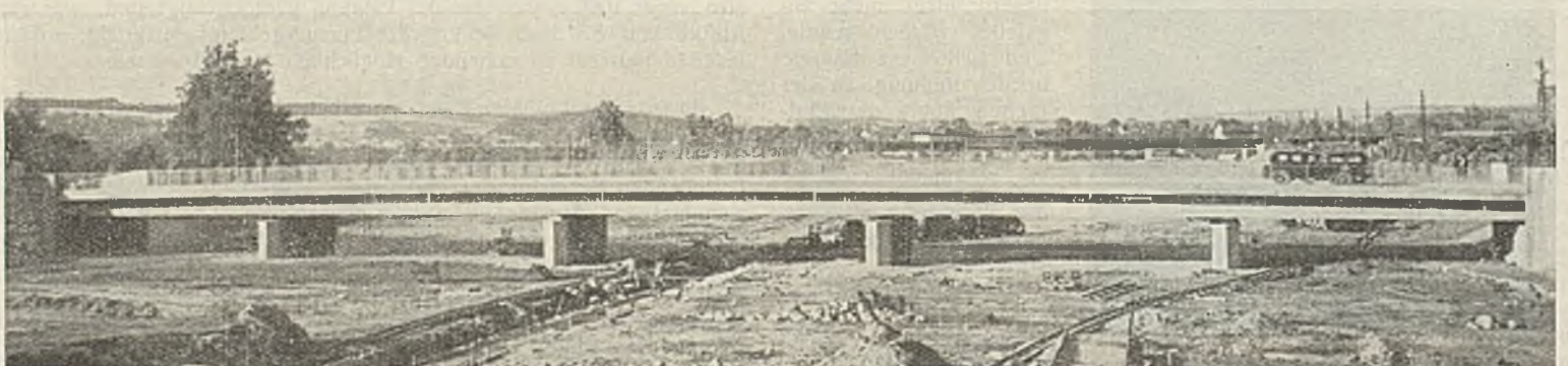
Abb. 6. Ansicht der Meeraner Brücke in Glauchau.
