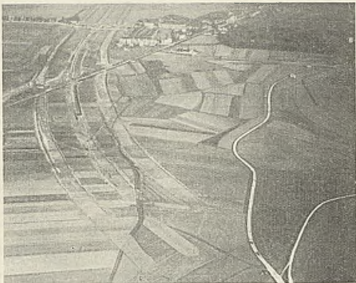
Abb. 7. Teilbild der Baustelle.
