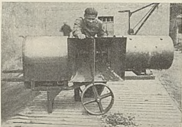
Kleiner Betonmischer (3 m 3 /h) für ununterbrochene Betonherzeugung.
