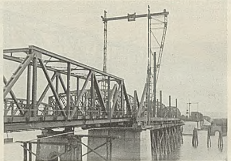
Abb. 8. Überbau 1-2 und 2-4 mit getrennten Auflagern.
