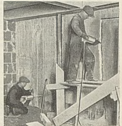
Abb. 2. Elektromagnetische Syntron-Hämmer im Betrieb. Hersteller: Thielicke & Co., Berlin SW 48.
