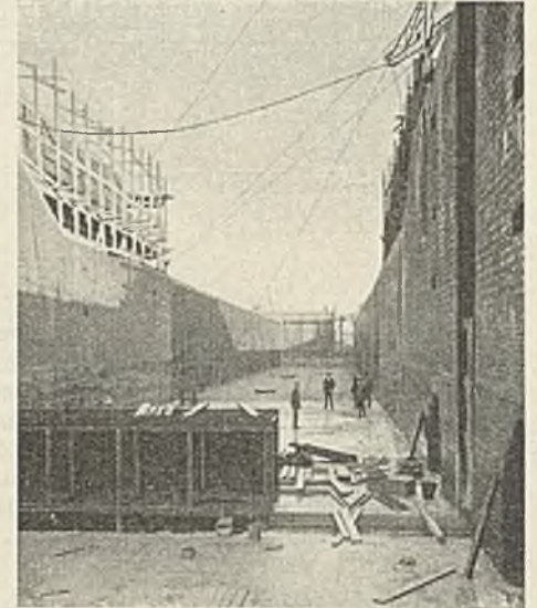
Abb. 12. Auspflasterung der Kammer.
