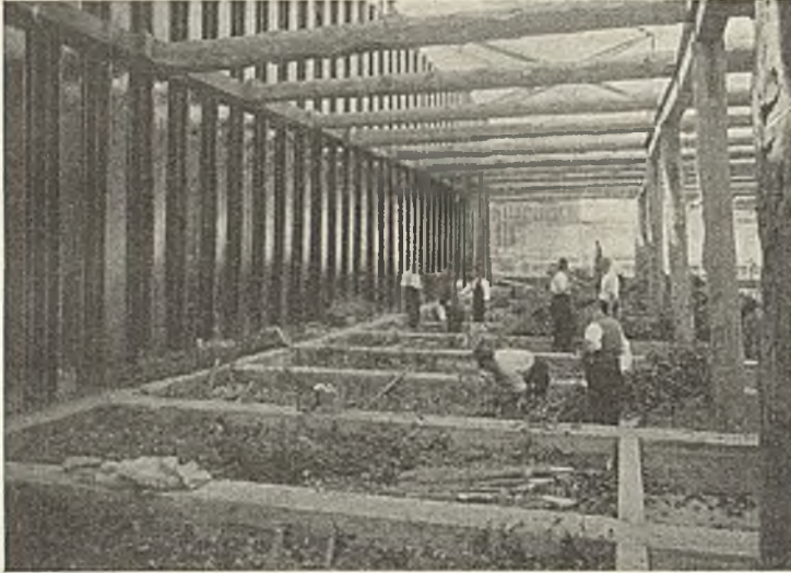
Abb. 11. Sohlenaussteifung und -befestigung der Kammer.
