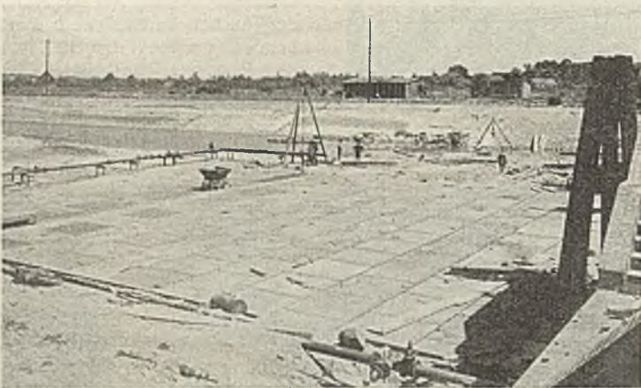
Abb. 14. Sohlenbefestigung der Vorhäfen.
