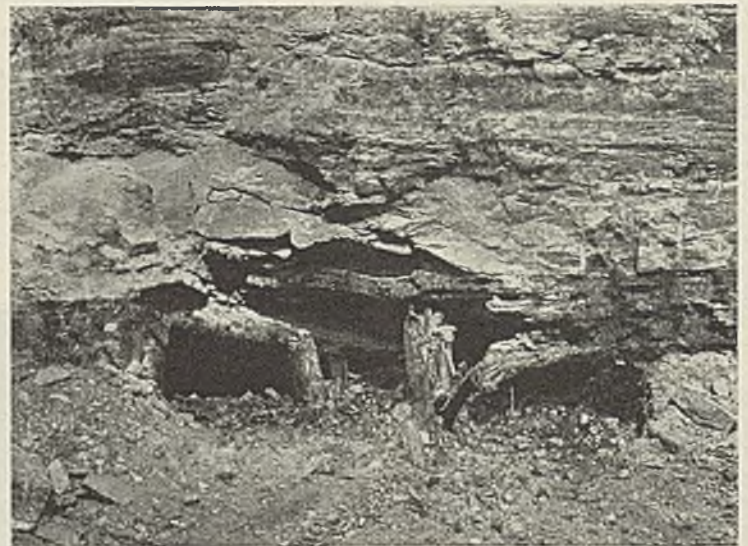
Abb. 11. Stempel der Zimmerung der Grubenbaue vom Abbau im Jahre 1804.
