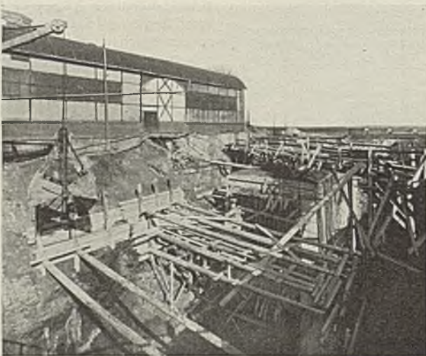
Abb. 9. Baugrubenaussteifung und Bau der Tunnelzonen.
