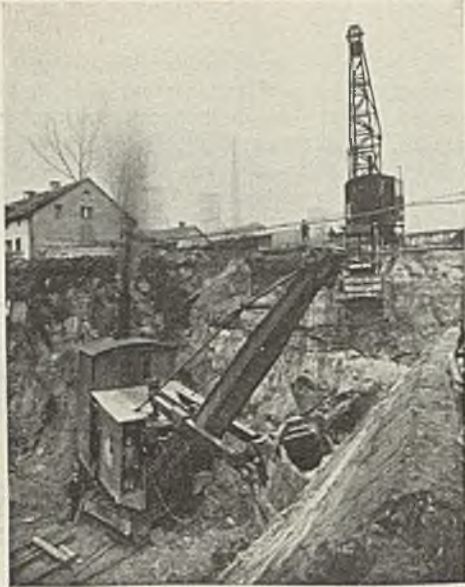
Abb. 7. Baggerung der Tunnelbaugrube.
