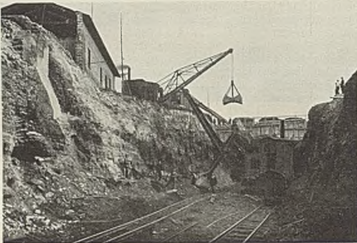
Abb. 8. Baggerung der Tunnelbaugrube.
