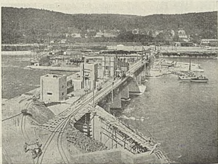
Abb. 27. Blick auf die fertiggestellte linke Wehrhälfte und obere Dienstbrücke.
