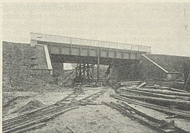
Abb. 10. Unterführung der Ebertstraße. Nordansicht. Bauabschnitt I.
