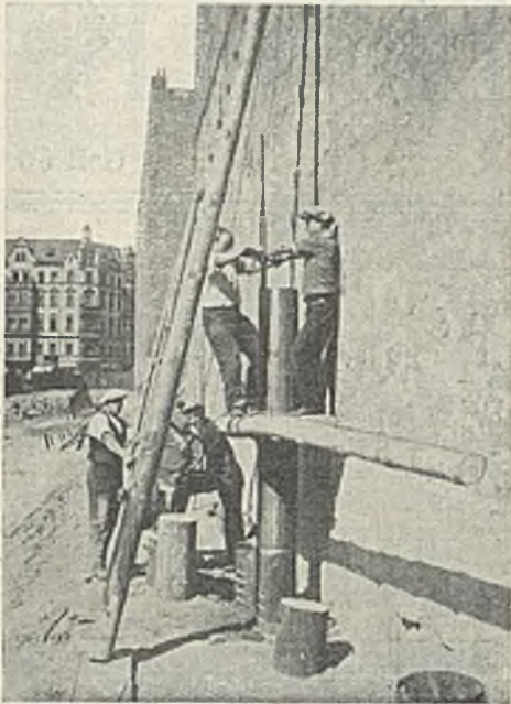
Abb. 5. Einbringen der Bohrpfähle außerhalb des Handamtes.
