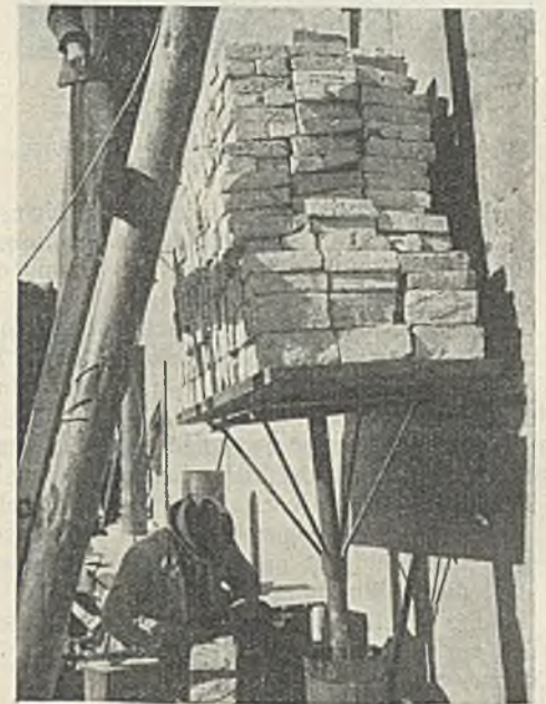
Abb. 3. Baugrundbelastung — System Lorenz — am Giebel des Handamtes.
