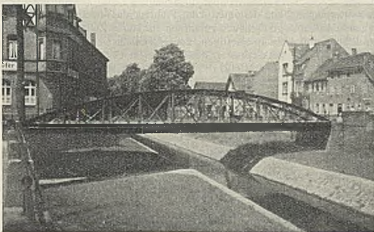
Abb. 1. Ansicht der alten Brücke von oberstrom.
