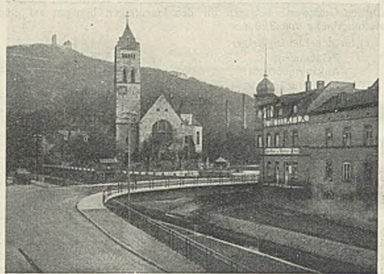
Abb. 9. Ansicht der neuen Brücke von unterstrom.
