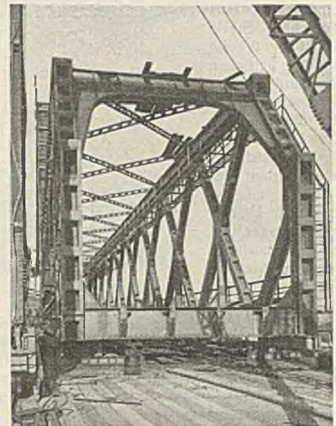
Abb. 41. Untergrabenbrücke mit Verschiebewagen.
