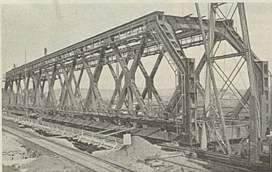
Abb. 40. Untergrabenbrücke. Zum Einschleiben fertig.
