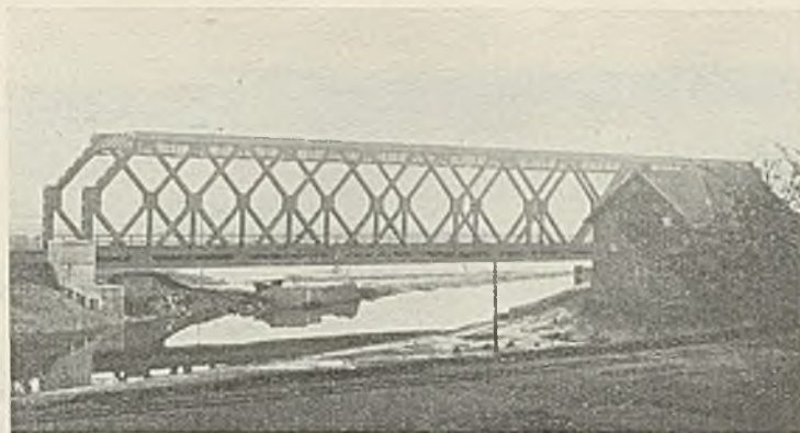
Abb. 44. Zweigleisige Eisenbahnbrücke über den Untergraben.
