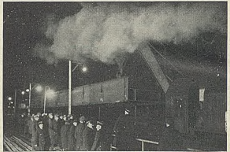
Abb. 12. Ausheben der alten Brücke bei Nacht.
