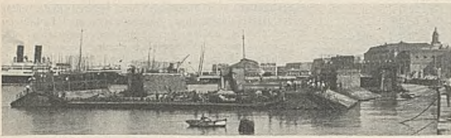
Abb. 7. Die drei ersten Senkkasten werden zum Zusammenbau eingeschwommen.
