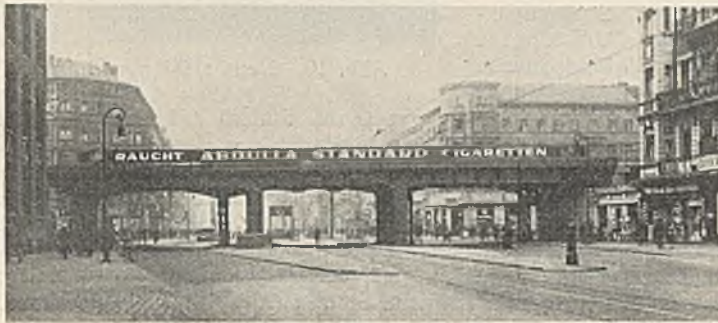
Abb. 3. Unterführung der Müllerstraße in Berlin.
