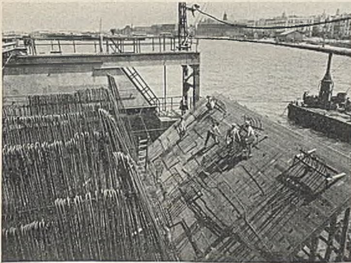
Abb. 4. Eisenverlegung für die Sohle und die Zwischenwände eines Senkkastens im Schwimmdock.
