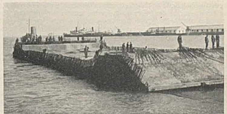
Abb. 6. Ein ausgedockter Senkkasten wird abgeschleppt.
