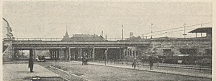
Abb. 8. Unterführung der Berliner Straße in Tempelhof.
