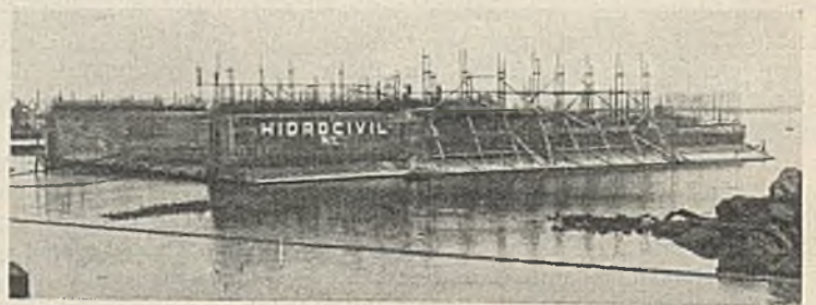
Abb. 10. Die ersten vier Senkkasten während des Zusammenbaues an der Dockbaustelle.
