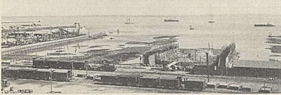
Abb. 11. Blick auf die Dockbaustelle mit vier zusammengebauten Senkkasten in der Bucht von Cadiz. Man erkennt die ausgebagerte Dockgrube und links im Hafenbecken den fertigen Pumpenhaus-Senkkasten.
