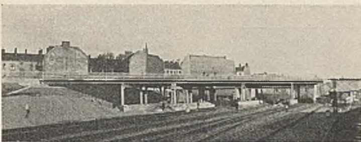
Abb. 5. Überführung der Ringbahn beim Bahnhof Ebersstraße in Berlin. Neues Bauwerk.
