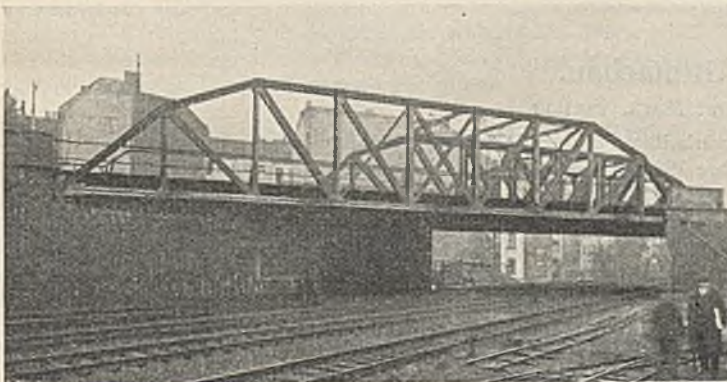
Abb. 4. Überführung der Ringbahn beim Bahnhof Ebersstraße in Berlin. Altes Bauwerk.
