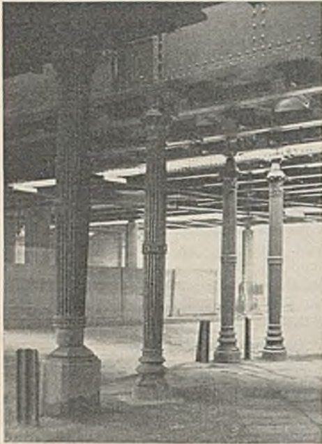
Abb. 9. Alte gußeiserne Säulen.
