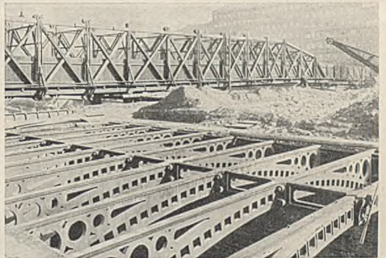
Abb. 4. Gußeiserne Tragkonstruktion der Brücke von 1865.
