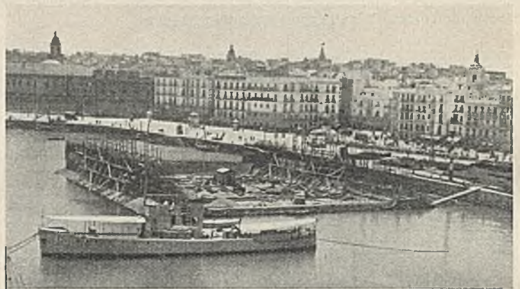
Abb. 9. Die drei ersten fertig zusammengebauten Senkkasten vor ihrem Abschleppen an die Dockbaustelle.
