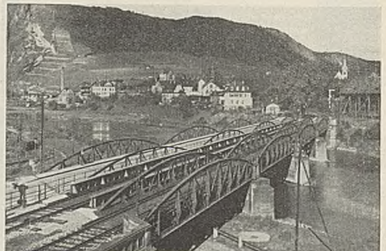
Abb. 26. Nahebrücke bei Ebernburg.
