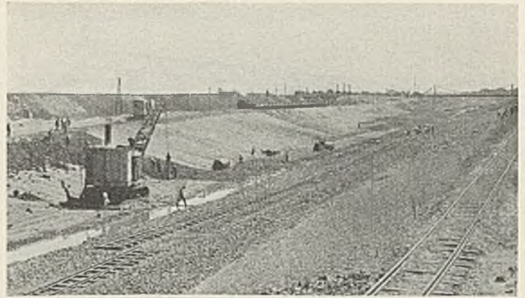
Abb. 14. Mittellandkanal. Einbringen der Tondichtung.
