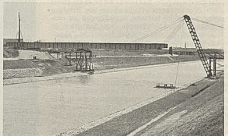
Abb. 17. Mittellandkanal. Bau der Fußgängerbrücke Wedesbüttel—Wedelheine.
