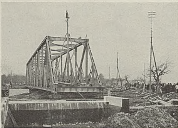
Abb. 16. Mittellandkanal. Staatsstraßenbrücke Gifhorn—Braunschweig.
