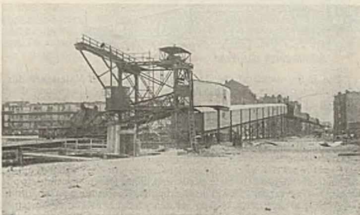
Abb. 1. Schaufelradbagger mit anschließendem, 320 m langem Förderband in einer Straße in Amsterdam.
