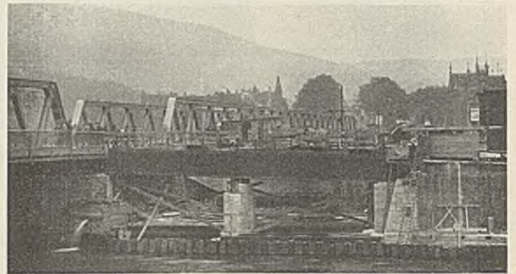
Abb. 6. Geschweißter Träger nach dem Einbau. Blick von der Wasserseite.
