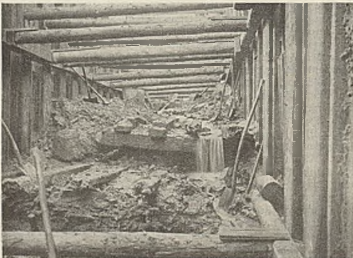
Abb. 6. Durchrammter doppelter Schwellrost.
