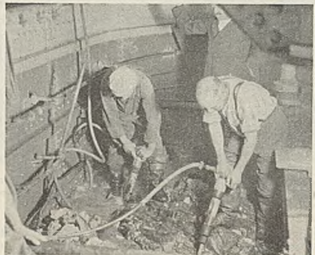
Abb. 31. II. Fahrt am Binger Loch. Im Taucherschacht.
